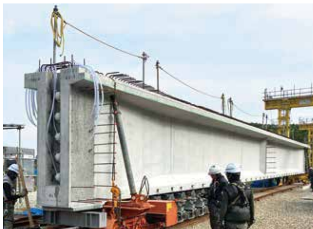
▲ 主桁送り出し状況
