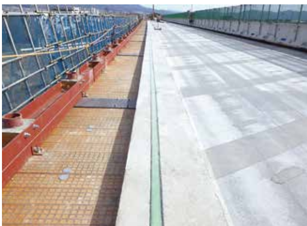
▲ 既設床版縦目地設置
