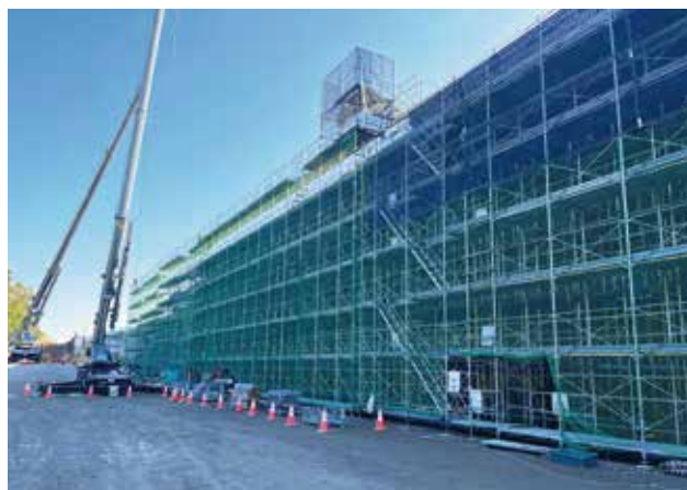
▲ 型枠支保工および足場組立完了
