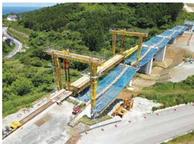
▲ 架設機材組立
