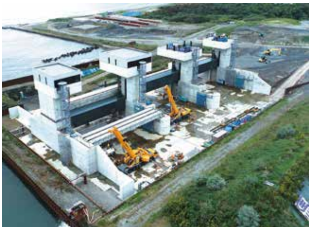
▲ 他工事と重複する現場の様子
