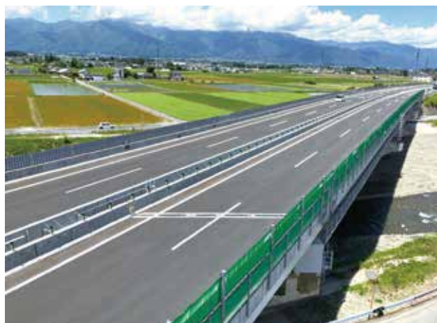
▲ 床版取替完了
