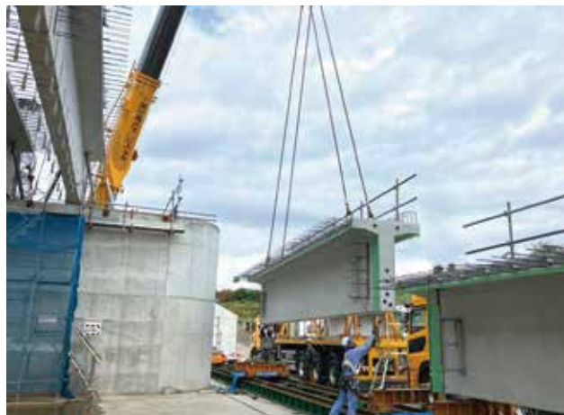
▲ 主桁の組立作業(セグメント取卸し)
