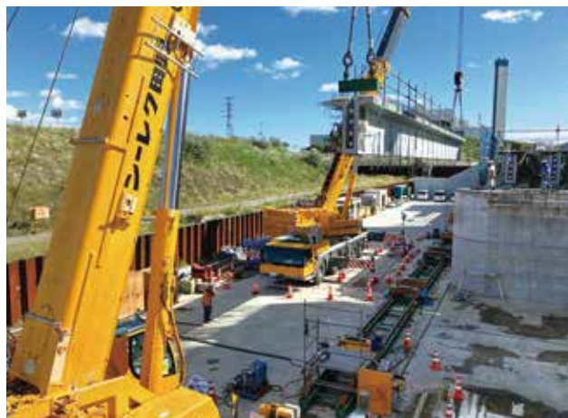
▲ 200t吊クレーン2台での相吊り架設
