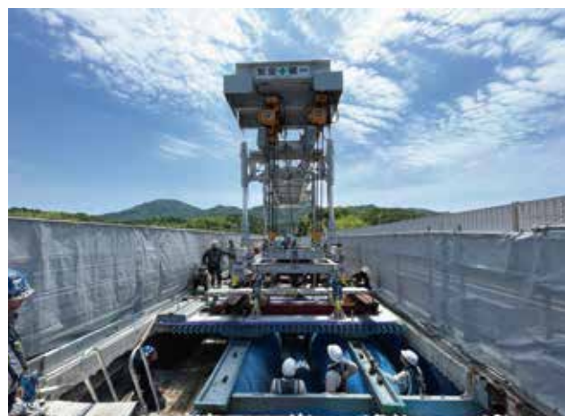
▲ SDRシステムによる床版架設
