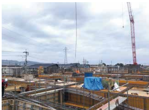
▲ PC鋼材挿入状況
