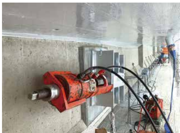
▲ 定着部外ケーブル緊張状況
