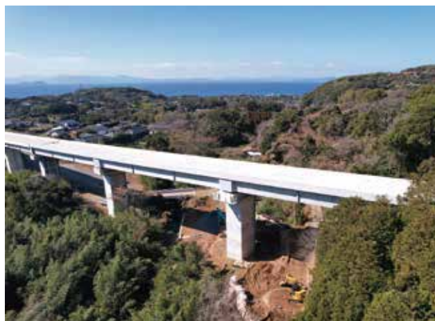
▲ A1-P3径間(施工範囲)
