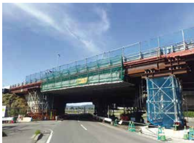
▲ 支柱式支保工構築
