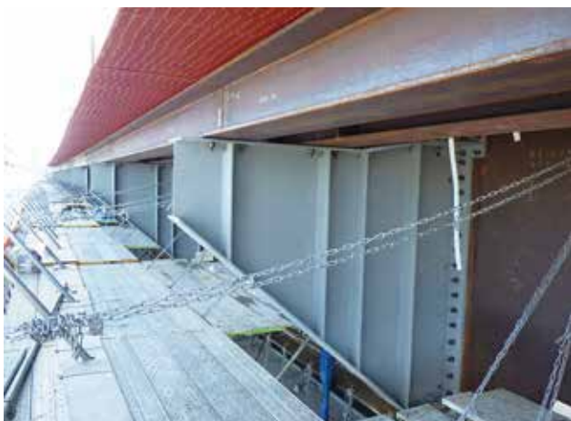
▲ 大型仮設ブラケット設置
