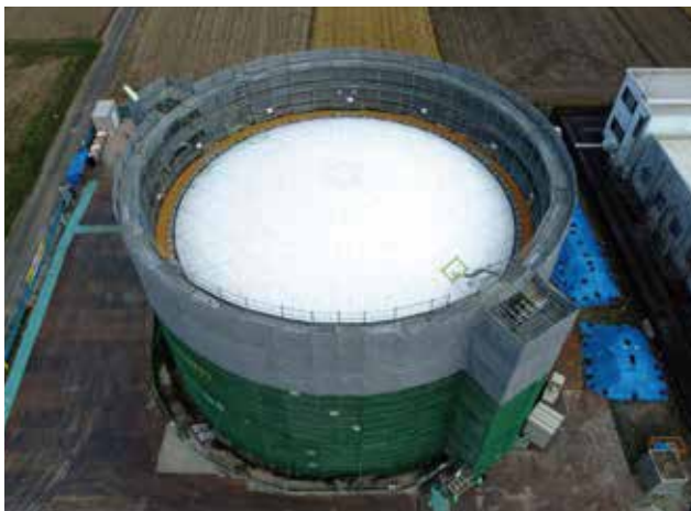
▲ エアードーム材材展設状況
