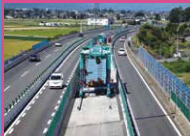
鎖川橋床版取替工事 (p.41)
