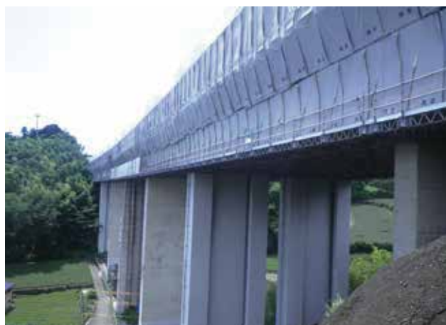
▲トラス橋足場状況
