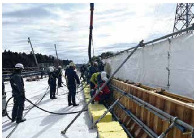
▲ I 期線への飛散防止養生(壁高欄Con打設時)
