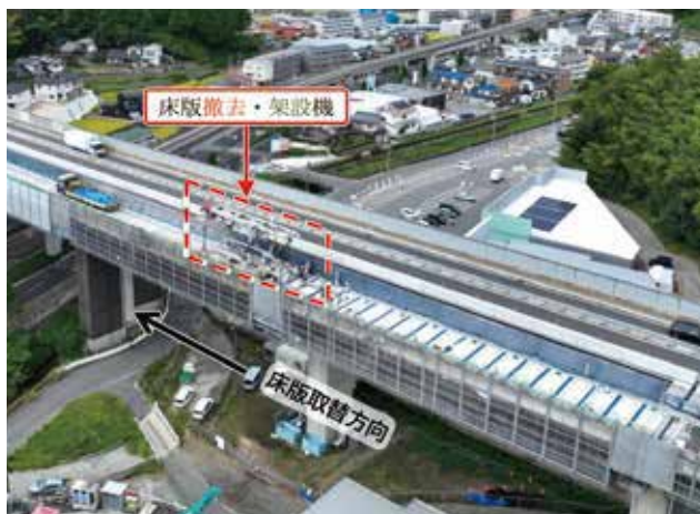
▲ シングルタイプ:1台の施工機械で撤去と架設を行う
