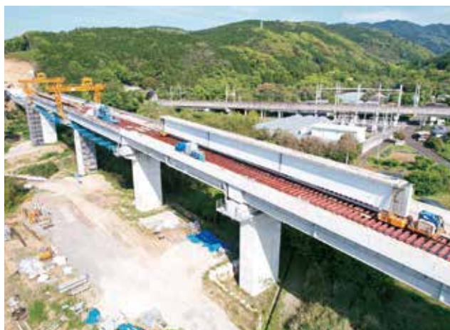
▲ A2橋台側からの主桁の引出し・架設桁架設
