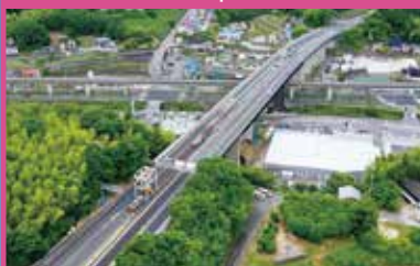
伴高架橋(上り線) 床版取替工事 (p.35)
