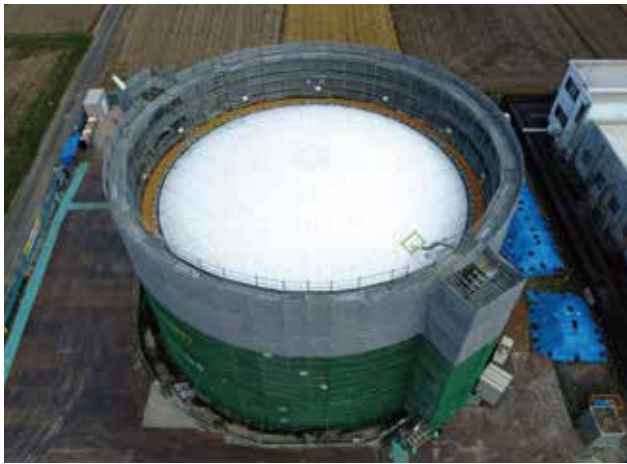
▲ エアードーム膜材展設状況
