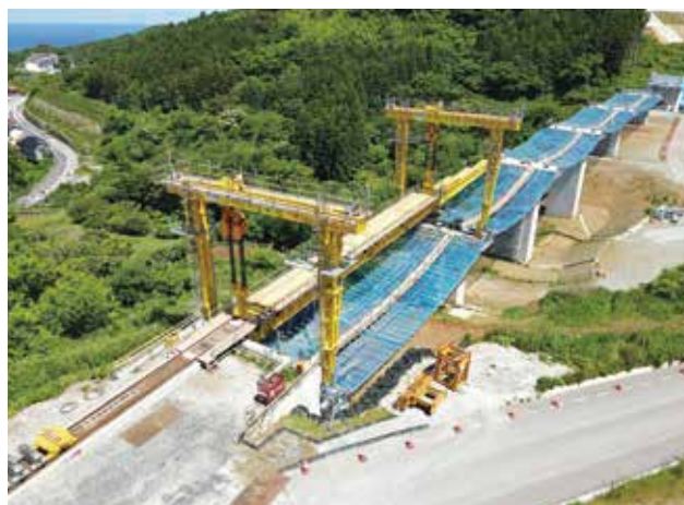
▲ 架設機材組立
