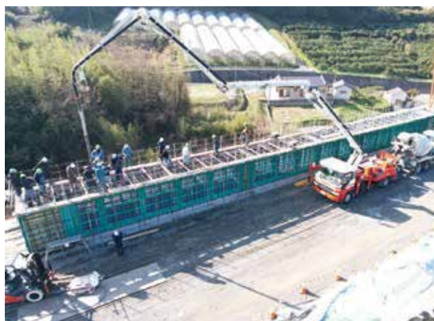
▲ 製作ヤードでの主桁製作
