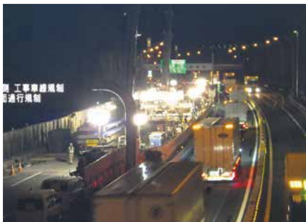
▲ 昼夜床版取替施工状況
