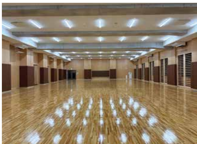
▲ 現場打ちPC梁が使用された屋内運動場棟
