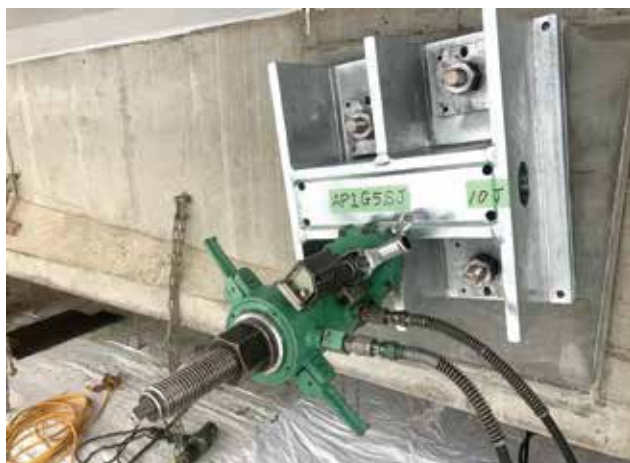
▲ 定着部PC鋼棒緊張状況
