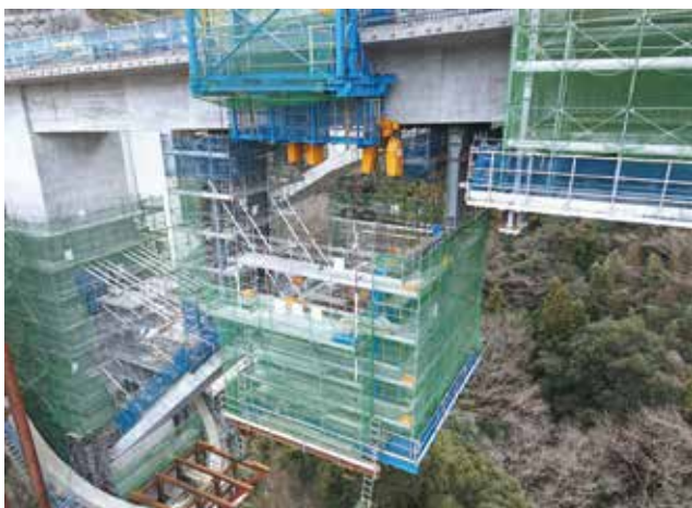
▲アーチリブ施工専用の移動作業車
