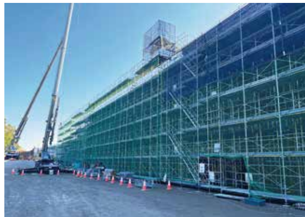
▲ 型枠支保工および足場組立完了
