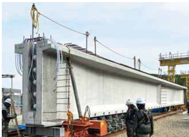
▲ 主桁送り出し状況
