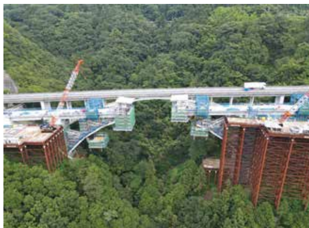
▲トラス張出し架設工法
