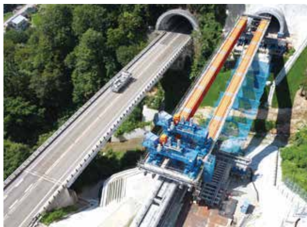
▲ 架設桁設置状況
