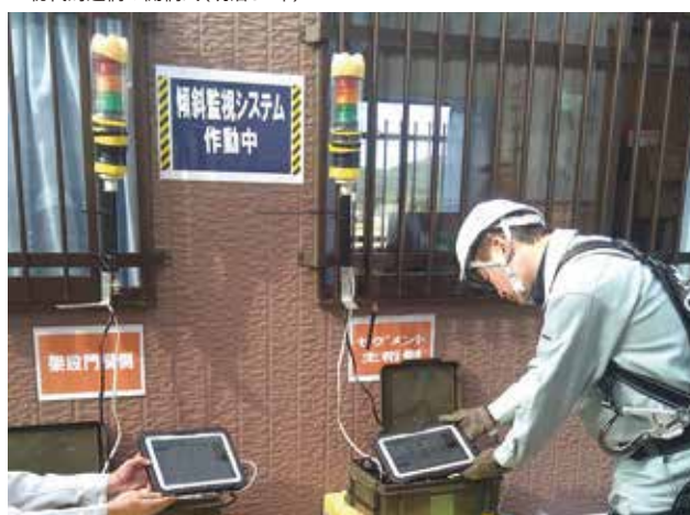
▲ リアルタイム傾斜監視システムによる安全対策
