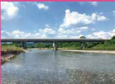
千足橋補強工事 (p.39)
