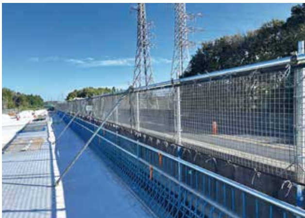
▲ I 期線への飛散防止養生(橋面施工時)
