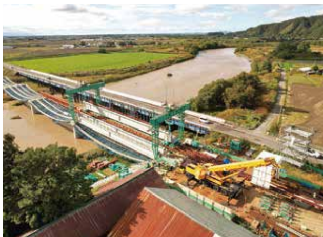
▲ 主桁架設状況
