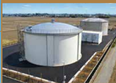
宮東No.2配水池 (p.29)
