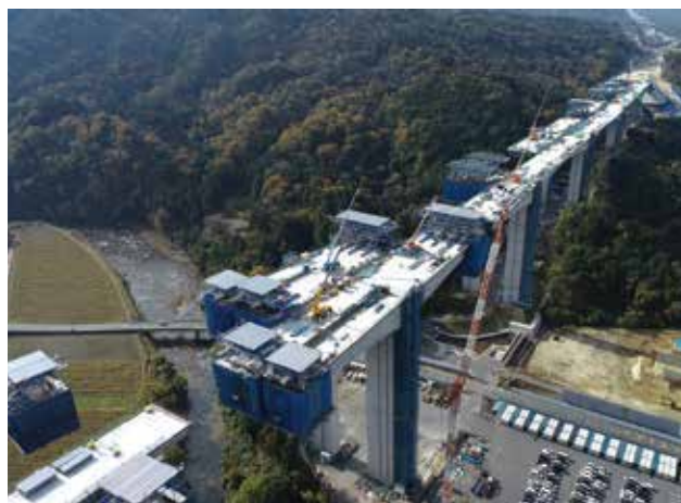
▲ 分岐部の片持架設状況
