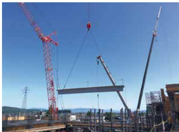
▲ コモンホール上部へのST板の架設状況
