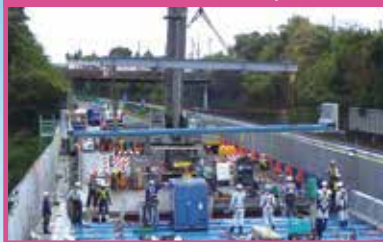
沼津IC～富士IC間床版 取替工事(平成30年度) (p.37)
