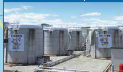
気仙沼油槽所 津波対応型燃油タンク(p.04)
