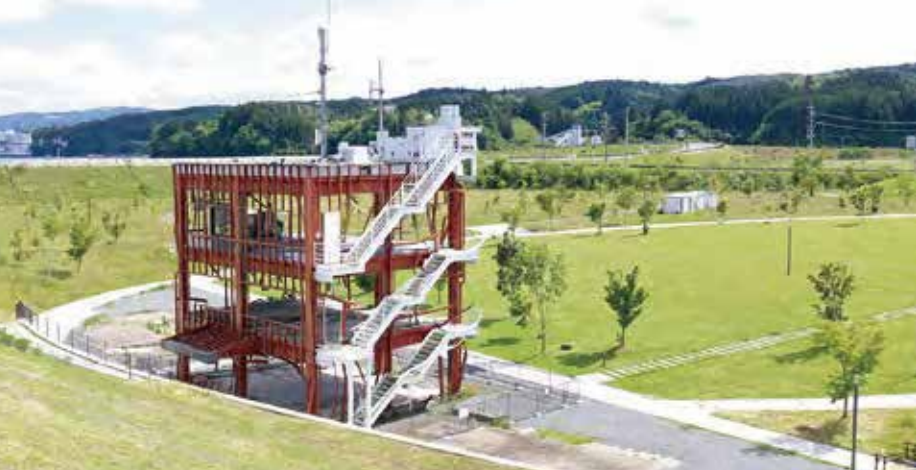
▲ 南三陸旧防災対策庁舎 昭和35(1960)年のチリ地震で南三陸町を襲った6.6mの津波を想定し、海拔1.7mの地盤に屋上の高さ12mの建屋を建設。避難場所でもあったが、3.11では15.5mの津波が襲った。
