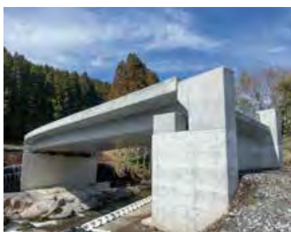
▲ 初めて照査を担当した橋梁
