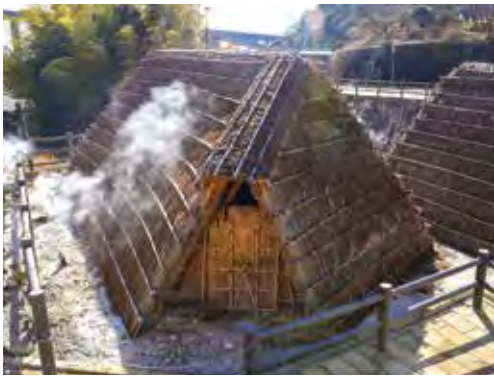
▲湯の花小屋(岡本屋旅館) わら屋根の中で温泉ガスの蒸気を結晶化させ、江戸期からミョウバン製造に使われた小屋。明治期に入浴剤として製品化。「小屋方式」での湯の花採取は明礬地域にのみ伝わる。
