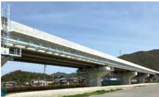
▲ 写真-1 岐阜市西郷地区の施工状況
