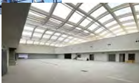
▶ 図5 膜屋根によって昼間の照度を確保したホール部(施工中)
