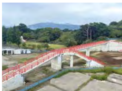
▲栃木県で施工した歩道橋
