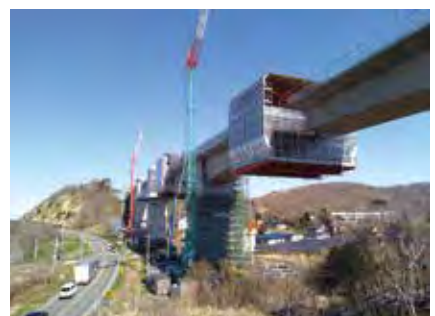
▲初めて従事した現場(北海道の箱桁橋)
