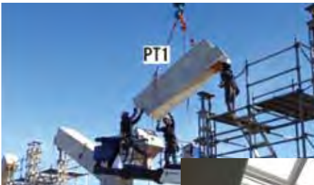
◀ 図4 アゴ形状を用いて施工性を高めたPT梁の架設
