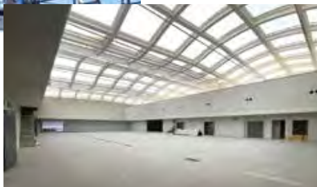
▶ 図5 膜屋根によって昼間の照度を確保したホール部(施工中)
