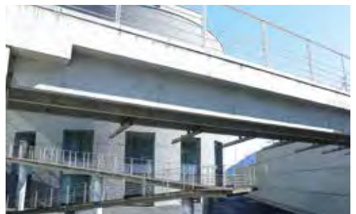
▼ 連絡橋 県道52号別府庄内線とコンベンションホールをつなぐ歩道橋。桁長約12.6m、幅員約2.0m、地覆から主桁までの橋体を工場にて一体で製作し現場まで運搬して架設。
