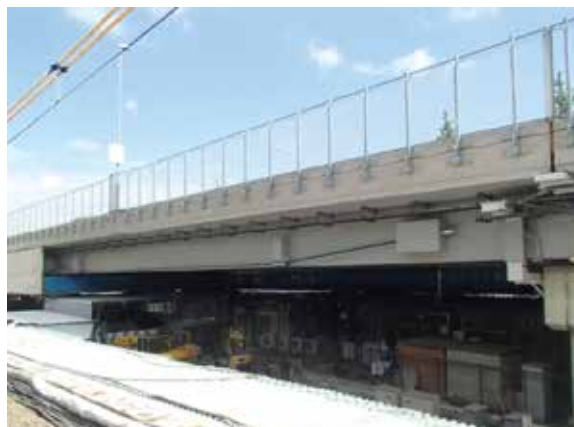
▲写真4 ゲルバー部連続化後の施工状況
