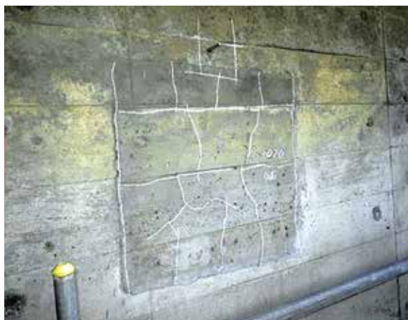
▲写真1 定着部後埋めコンクリートのひび割れ
