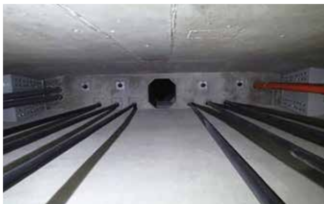
▲写真4 外ケーブル補強事例 箱桁
