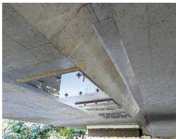
▲写真3 突出防止対策の試験施工状況
