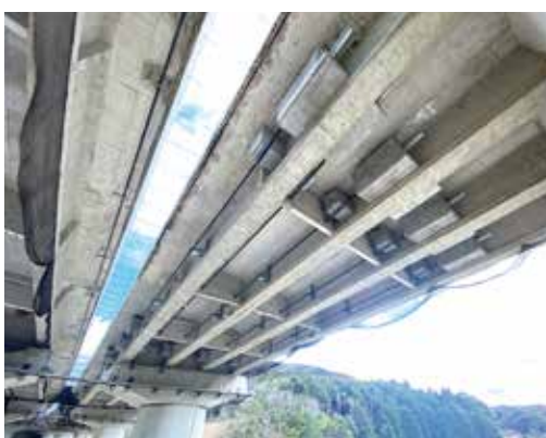
▲写真1 補強完了
