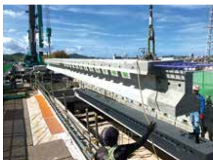
▲ 桁取替工事
