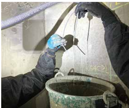
▲写真1 PCグラウト再注入工
