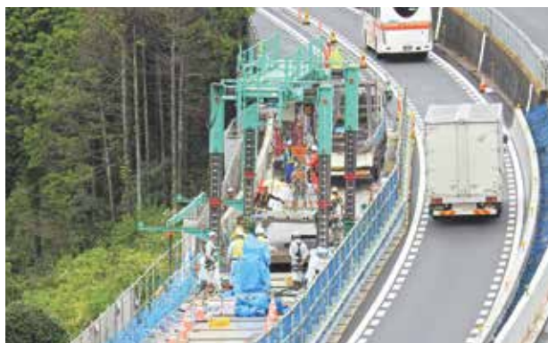
▲写真2 床版架設機(半断面)
