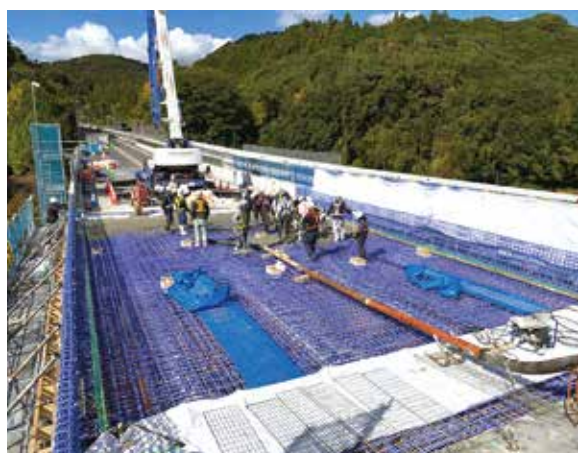
▲写真3 コンクリート打設
