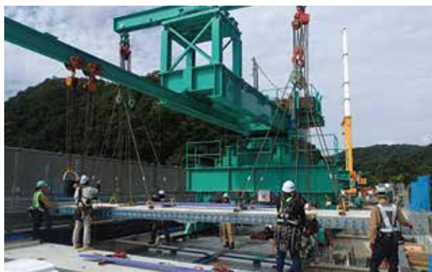
▲写真1 床版架設機(全断面)
