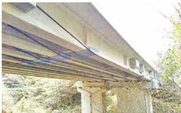
▲写真3 外ケーブル補強事例 T桁
