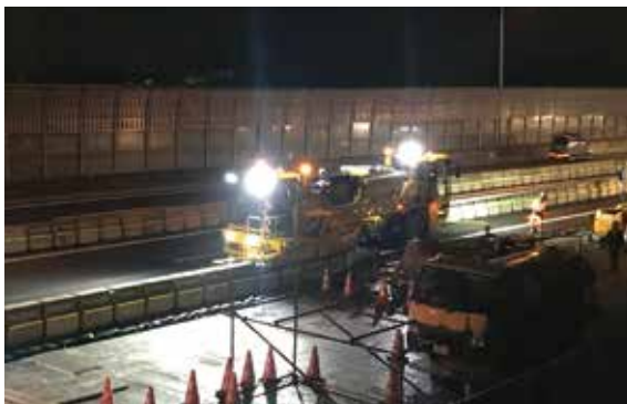
▲写真1 防護柵切替用車両による固定規制帯の拡張
