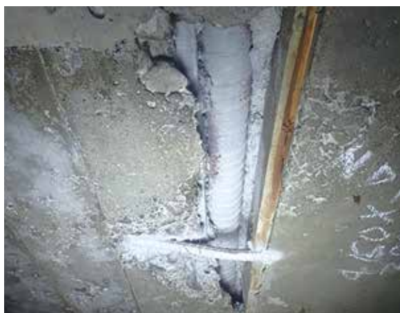
▲写真2 シース管の露出
