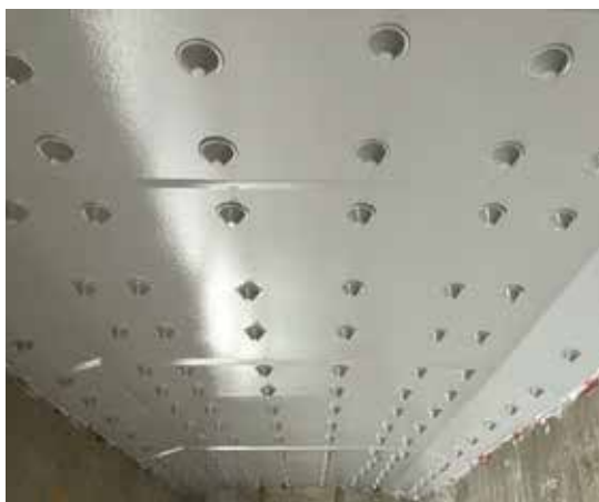
▲写真2 鋼板接着工
