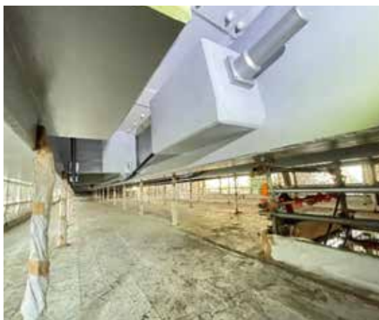
▲写真3 クイーンポスト配置での外ケーブル工
