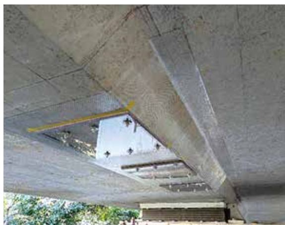
▲写真3 突出防止対策の試験施工状況
