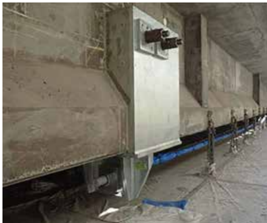
▲写真4 直線配置での外ケーブル工
