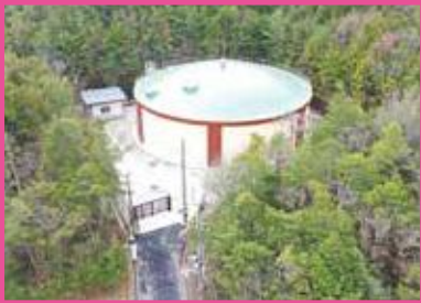
山中配水池防水工事 (p.35)
