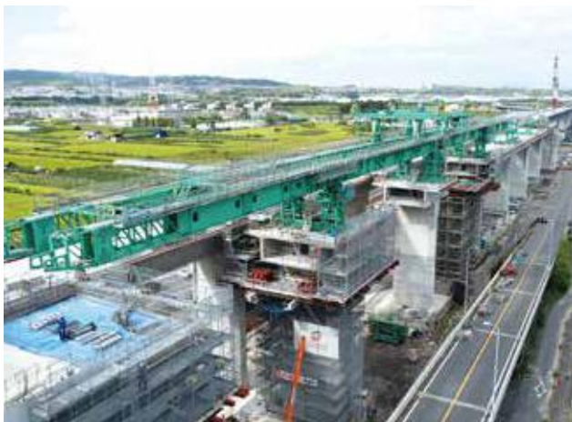
▲ 架設桁架設状況
