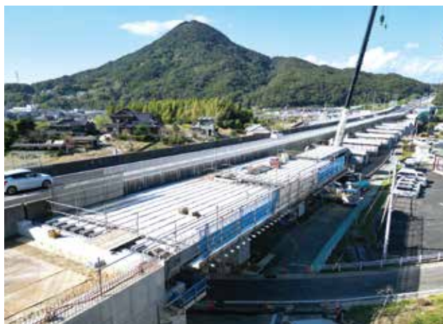
▲ 竹辺1号橋主桁架設
