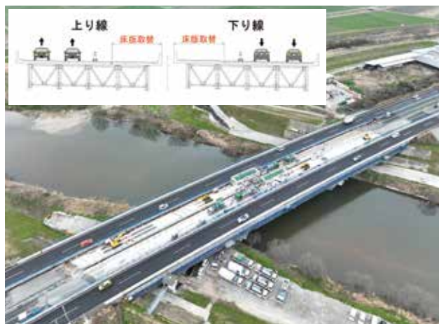
▲ 全体写真(第一期 1～4月)
