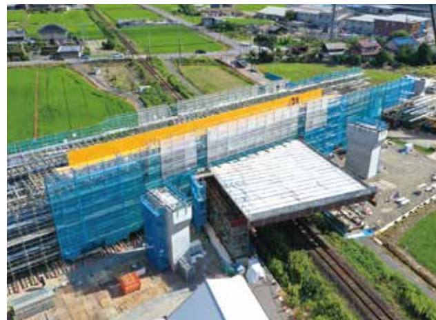
▲ 樽見鉄道の安全対策 鉄道道を全面防護
