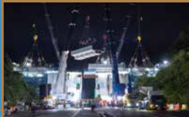
杉谷第2跨道橋 撤去工事 (p.27)
