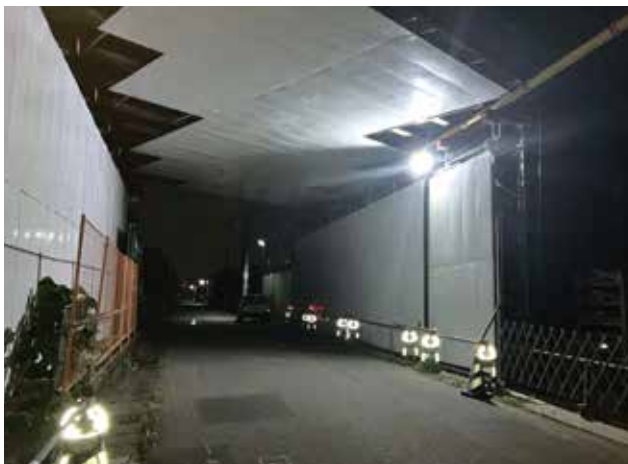
▲ 市道の安全対策 白い板で視認性を高めた
