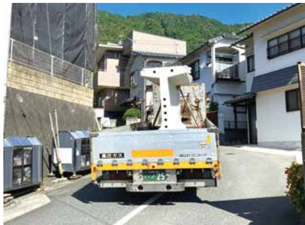
▲ セグメント桁運搬状況
