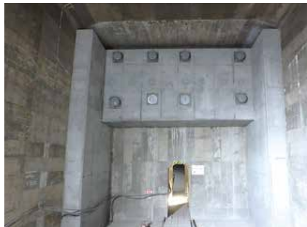
▲ 外ケーブル定着部周りの横桁補強
