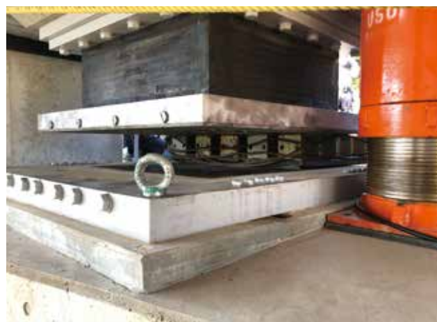
▲ ジャッキダウン工法
