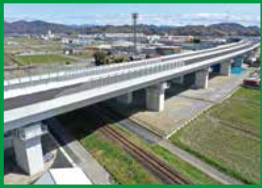
見延第一高架橋 (p.15)
