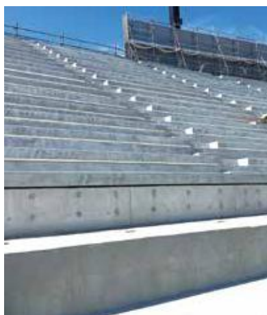
▲ 整然と並ぶPC段床板
