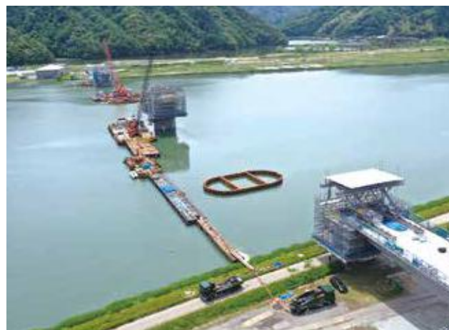
▲ コンクリート打設(船上圧送管配置)
