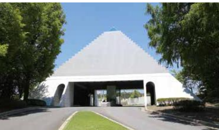
▲名古屋商科大学日進キャンパス 万博記念ゲート 平成17(2005)年に完成した、キャンパスの通行用ゲート。階段状に配置したプレキャスト部材や通路上部の梁や地中梁にもプレストレストコンクリートを採用。
