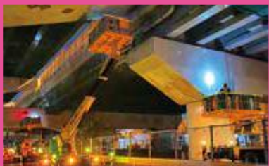
松原線PC桁 大規模修繕工事 (p.37)
