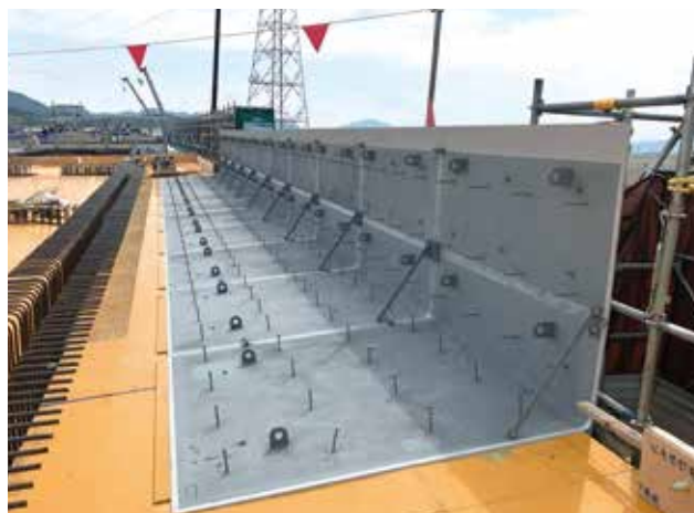
▲ 埋設型枠設置
