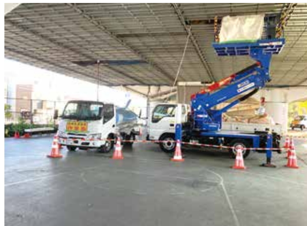
▲ 公園内規制による無収縮モルタル打設
