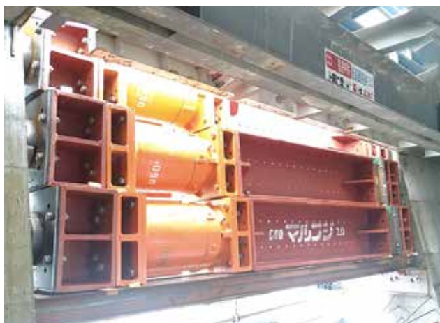
▲ 水平反力調整工
