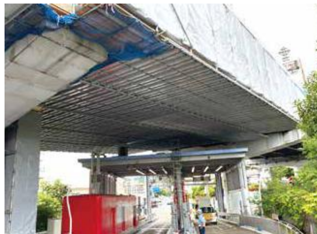
▲ 月見山料金所足場設置
