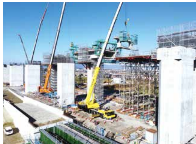
▲ クレーン架設状況
