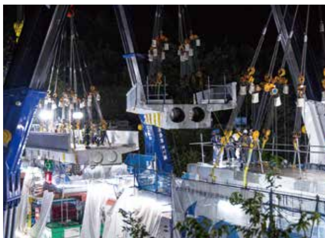
▲ ブロック撤去状況
