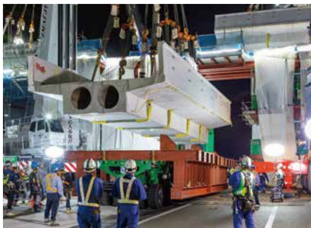
▲ ブロック撤去状況
