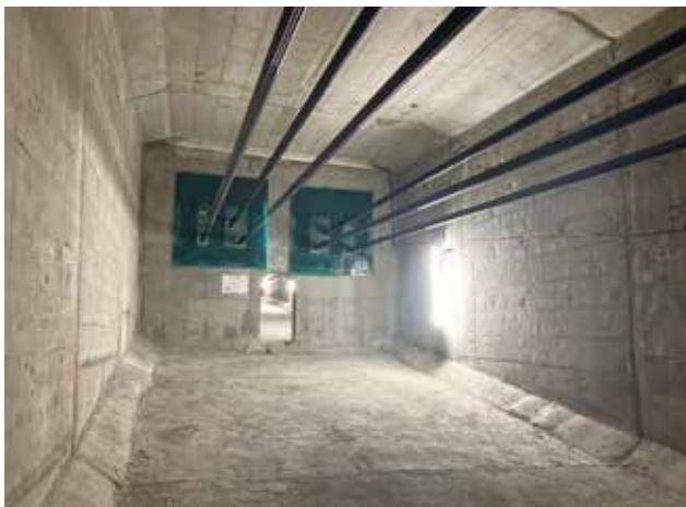
▲ 連続化に伴う外ケーブルと炭素繊維シートによる補強
