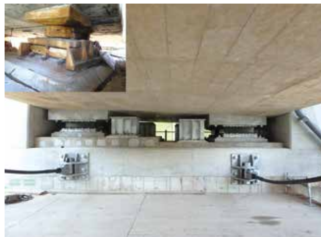
▲ ゴム支承への取替 (左上: 取替前支承)
