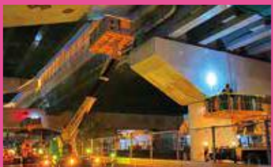
松原線PC桁 大規模修繕工事 (p.37)
