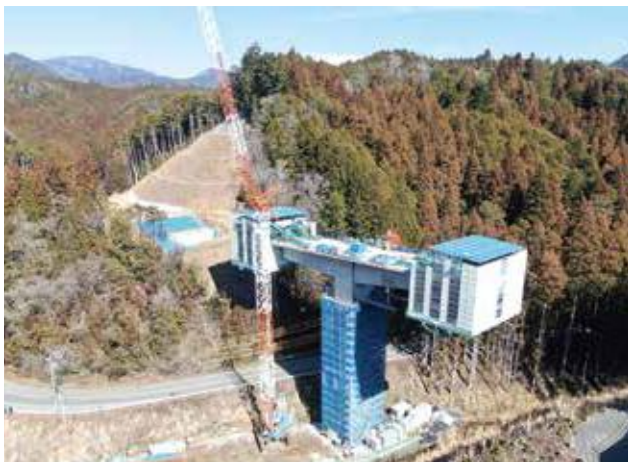
▲側面底面を完全防護しながらの片持架設状況
