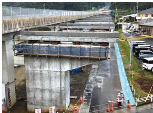
▲ 竹辺1号橋横梁先行架設完了
