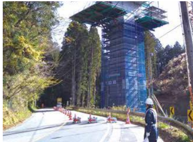
▲移動作業車組立時などに片側交互規制の実施
