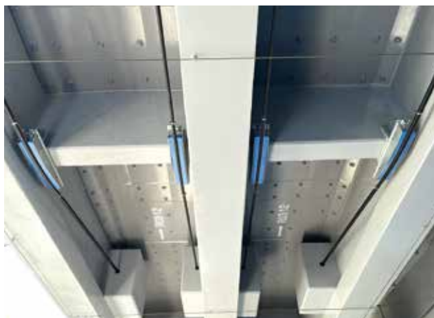
▲ 外ケーブル外観
