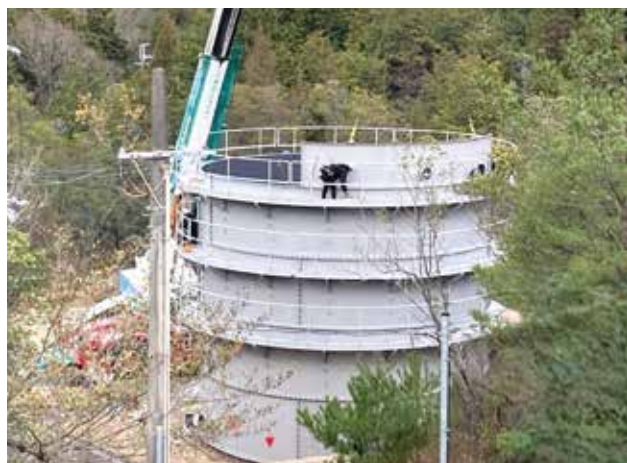
▲ 仮設タンクの組立
