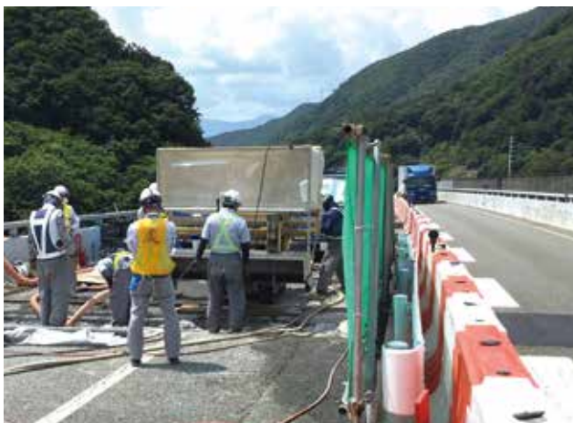
▲ 片側規制しながらのジョイント交換作業
