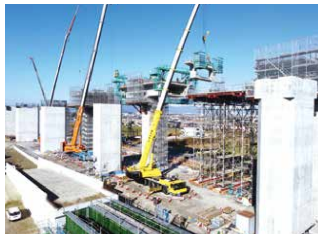
▲ クレーン架設状況
