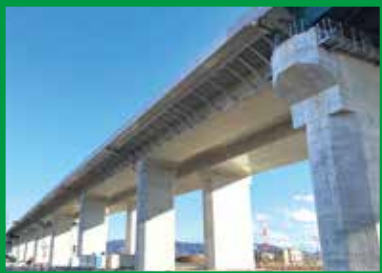
城陽第二高架橋(P30-P39) (p.17)
