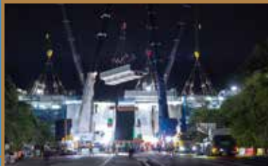
杉谷第2跨道橋 撤去工事 (p.27)
