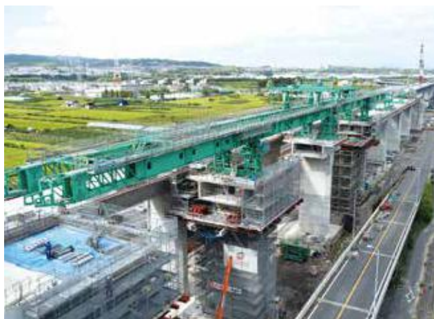
▲ 架設桁架設状況
