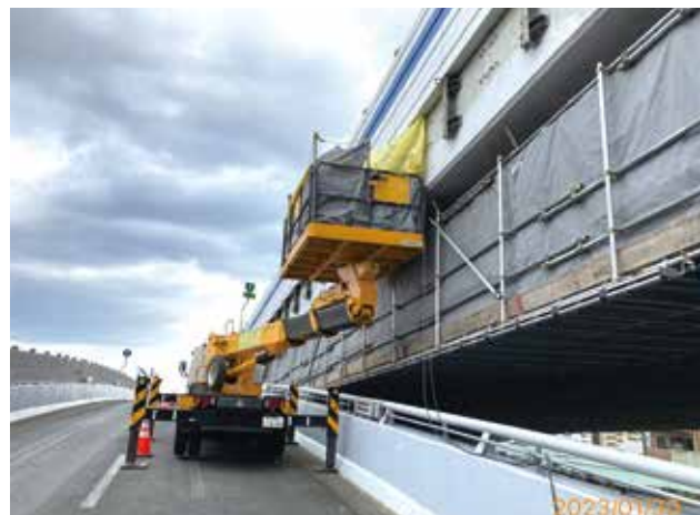
▲ ランプ規制による既設表面保護撤去
