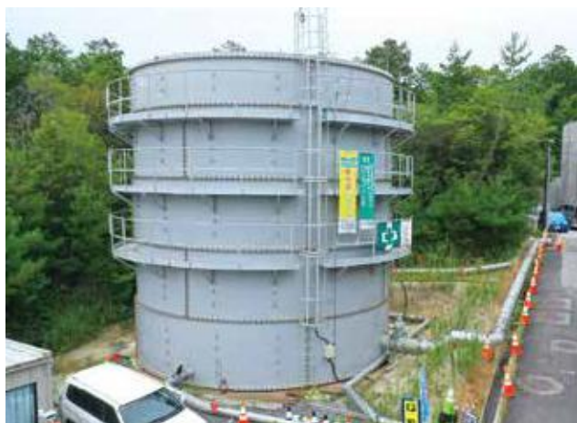
▲ 仮設タンク稼働中
