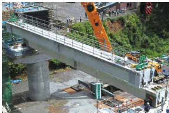
▲ プレキャスト桁クレーン架設状況
