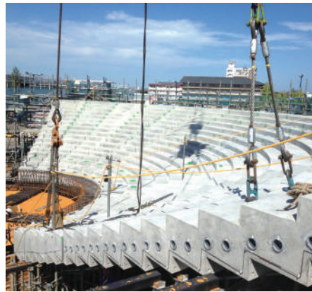
▲写真5 ふわふわコフン施工状況
