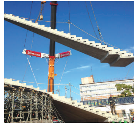
▲写真4 インフォ＆ラウンジコフン施工状況
