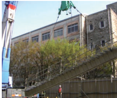
▲写真6 現場施工時（撮影：ピーエス三菱）
