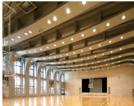
▲ 写真4 体育館内観写真
