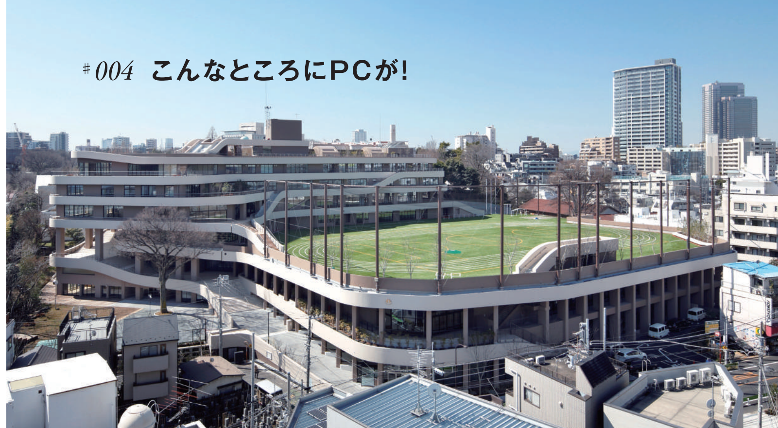
▲ 写真1 外観写真
