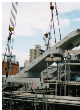
PC 屋根版建方状況
