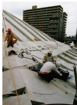
PC 屋根版緊張状況
