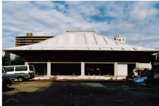
構造躯体完成写真
