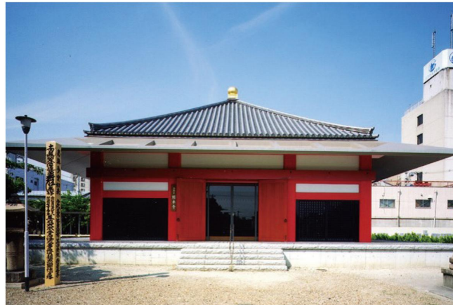
竣工後の本堂正面
