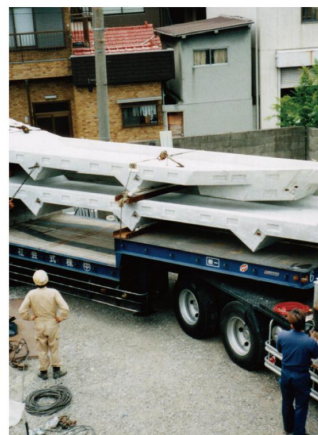
PC 屋根版搬入状況
