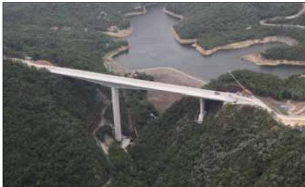
写真-1 川下川橋(連続ラーメン箱桁橋)
