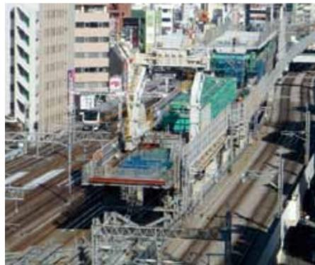
写真-1 PC桁組立状況
