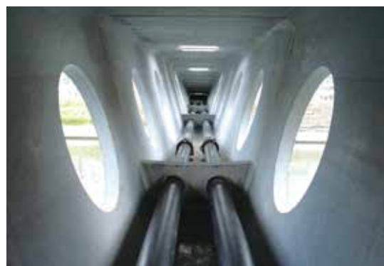
▲ 写真-5 大型開口部と桁内の外ケーブル
