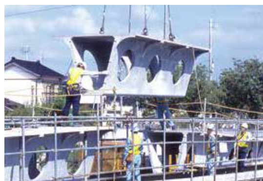
▲ 写真-6 センターブロックの架設
