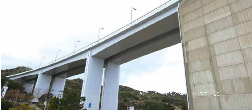
▼ 松帆高架橋 橋長300mのPC4径間連続ラーメン箱桁橋。世界最大級の吊り橋である明石海峡大橋のアプローチ橋。
