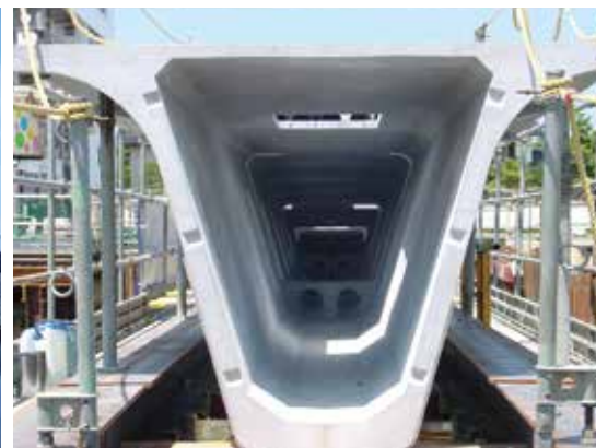
▲ 写真-3 桁断面
