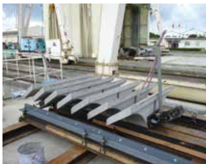
▲ PC 階段の組立状況
