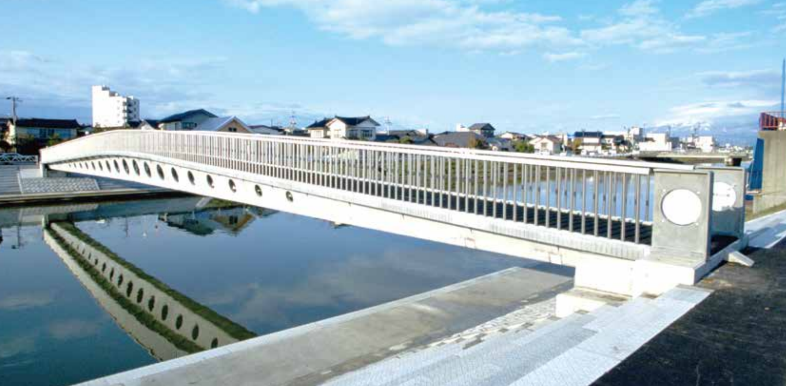
▲写真-1 酒田みらい橋
