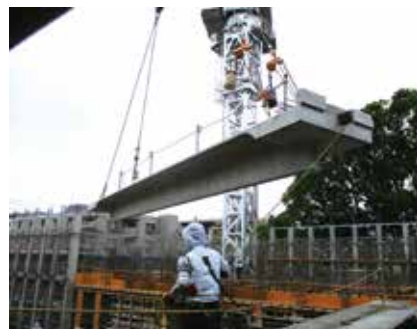
▲ ST版の架設状況
