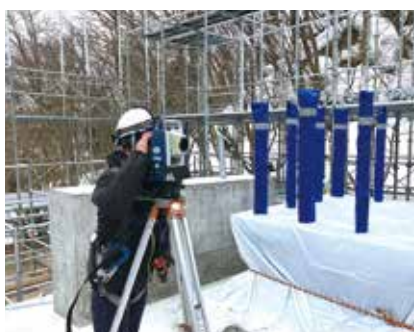
▲ 施工中の現場で測量している様子
