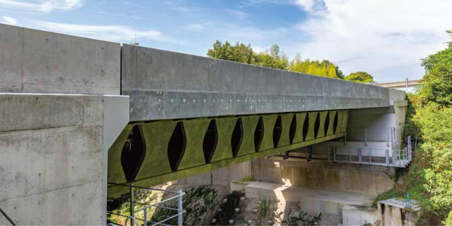
▲写真-1 別埜谷橋全景
