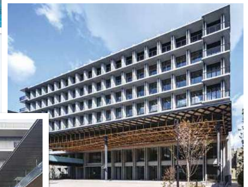
荷揚複合公共施設
