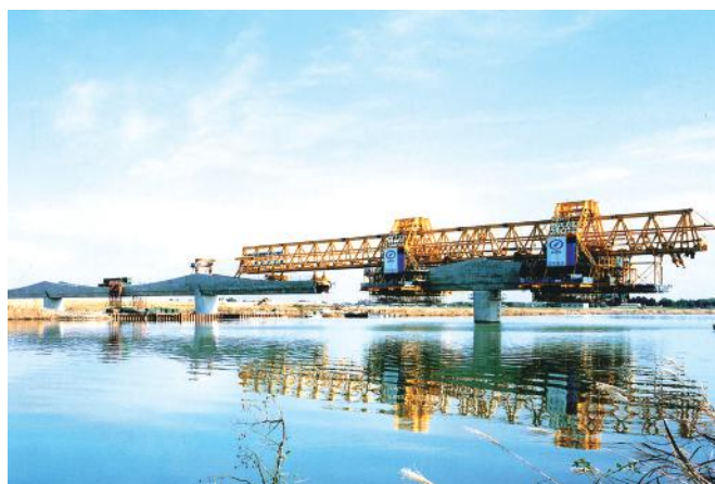
▲ 写真-2 P&Z装置による架設
