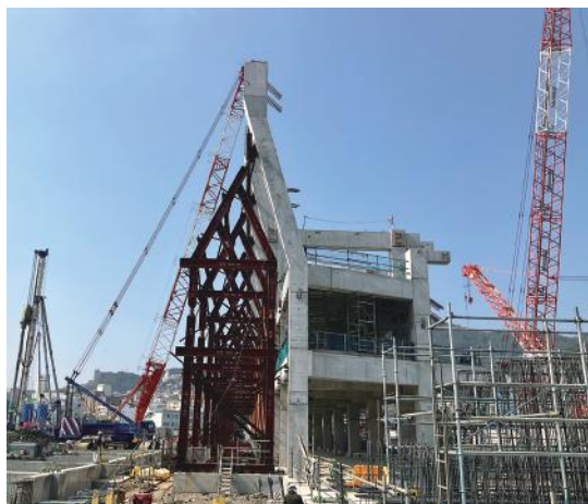
▲ 2層柱プレキャスト部材
