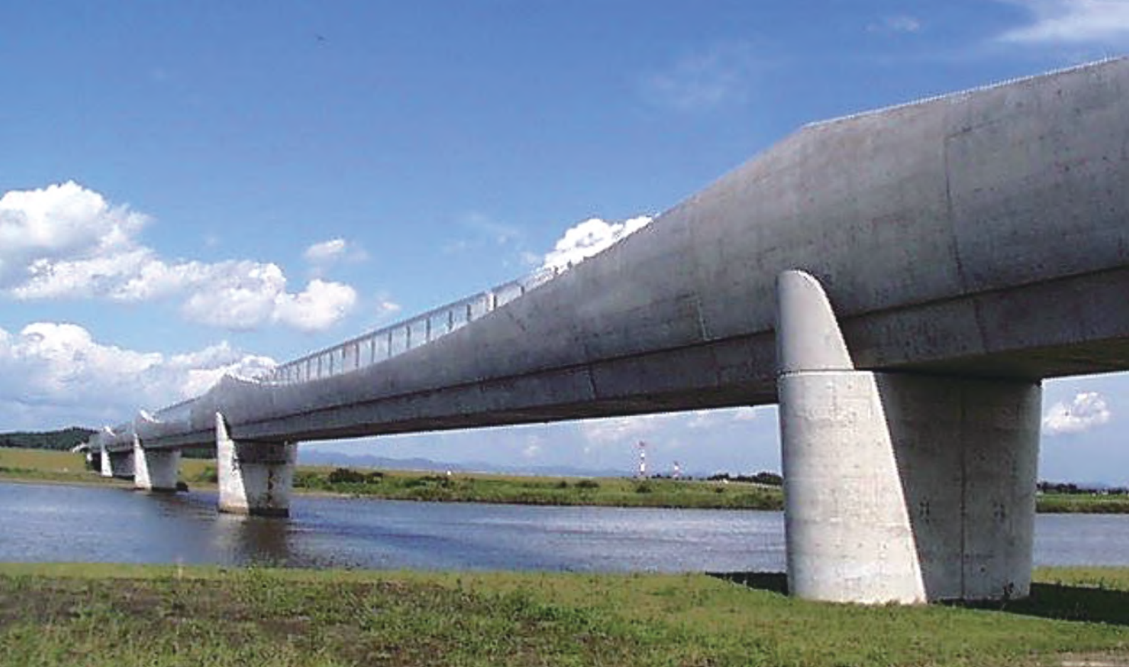
▲ 鳴瀬川橋梁全景
