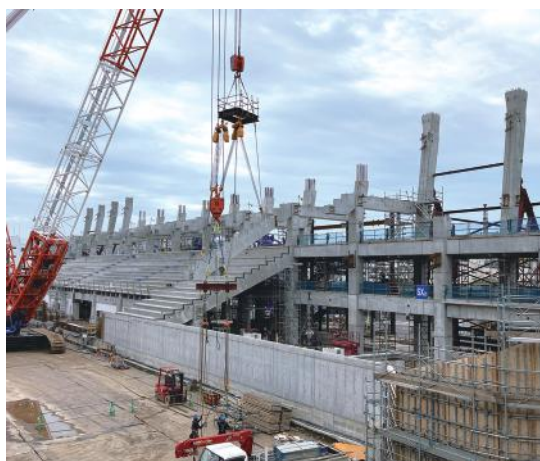
▲ 段梁プレキャスト部材
