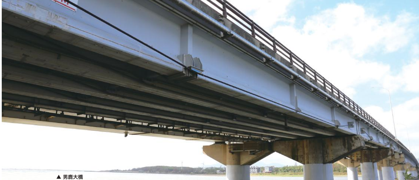
▲ 男鹿大橋 平成14(2002)年に拡幅工事と同時に、活荷重の増大への対策として外ケーブルの補強工法を、塩害対策として電気防食工法を実施。
