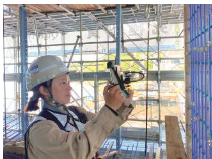
▲ 現場での作業
