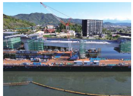
▲ 移動作業車を用いた片持架設工法
