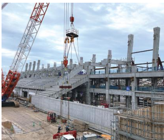
▲ 段梁プレキャスト部材
