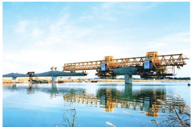
▲ 写真-2 P&Z装置による架設
