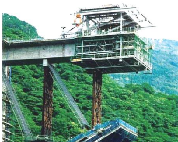
▲写真-3 特殊大型移動作業車による施工
