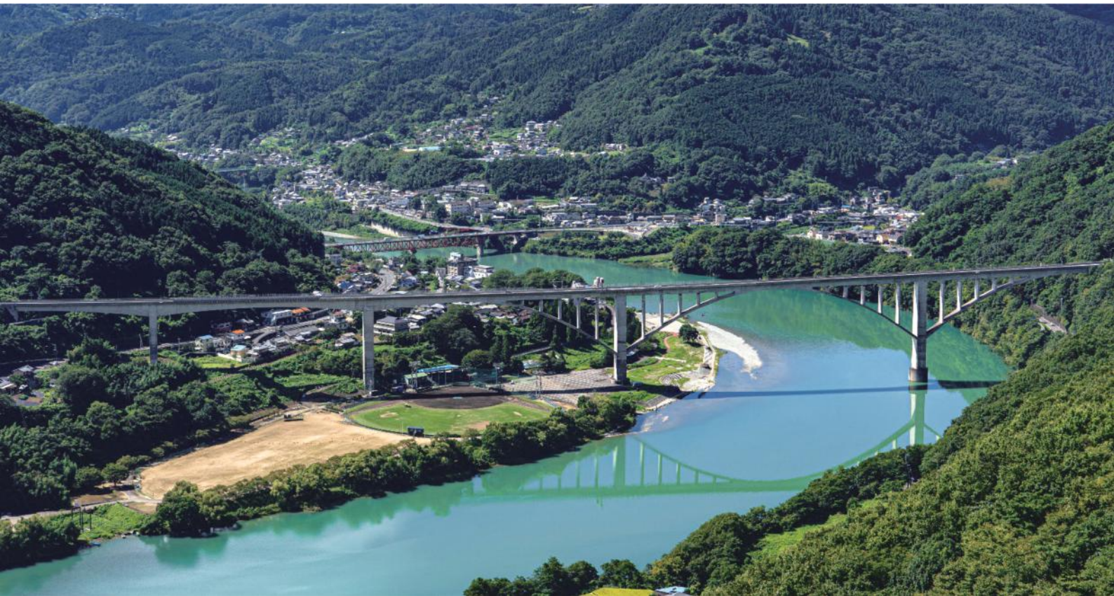
▲写真-1 池田へそっ湖大橋全景
