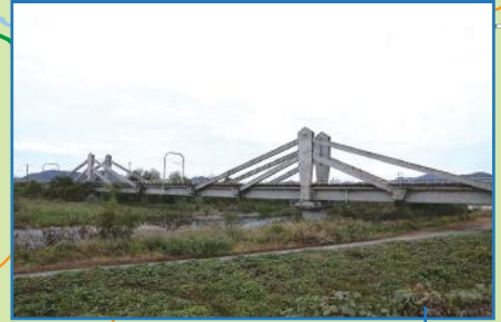
第一玉川橋梁 (p.03)
