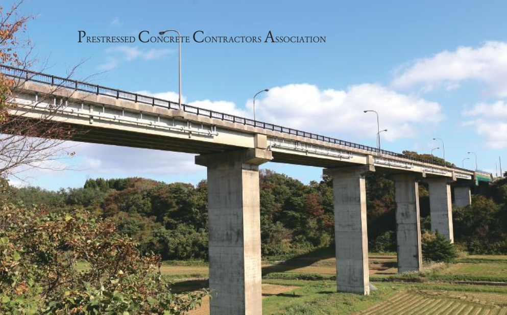
◀▲ なまはげ大橋 男鹿国定公園の外周にあるドライブルート、なまはげラインに架かる橋長250mのPC6径間連結T桁橋。親柱になまはげの銅像が立つ。
