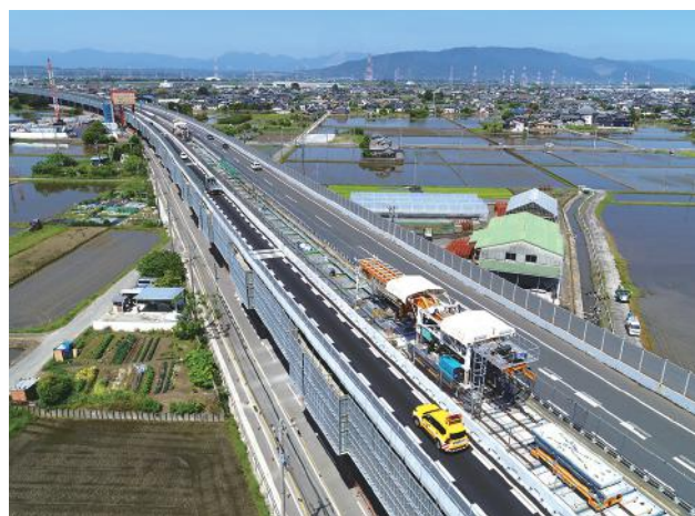
▲ 床版取替施工状況 (Ⅱ期追越側施工時)
