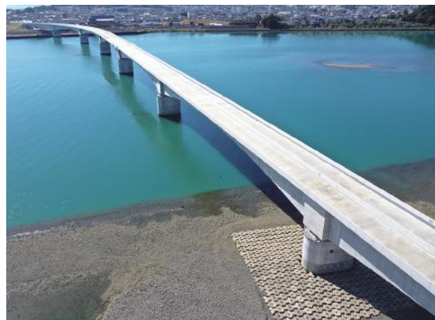
▲ 完成写真 三重県側から
