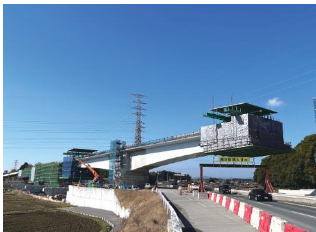
▲ 道路上での移動作業車を用いた片持架設
