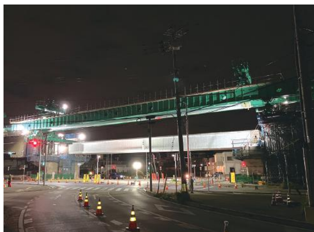
▲ 架設桁による主桁架設状況
