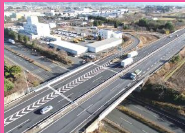
清水第二跨道橋 (p.32)
