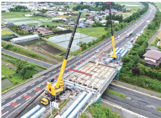
▲ 床版架設状況
