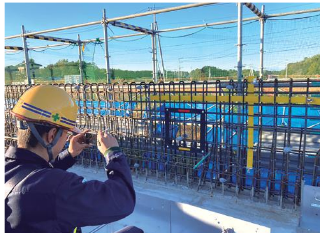
▲ 配筋状態撮影
