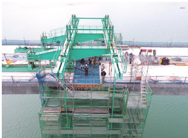
▲ 施工状況 中央閉合部
