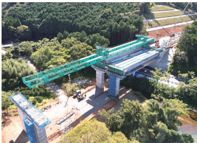
▲ 二組架設桁による架設状況
