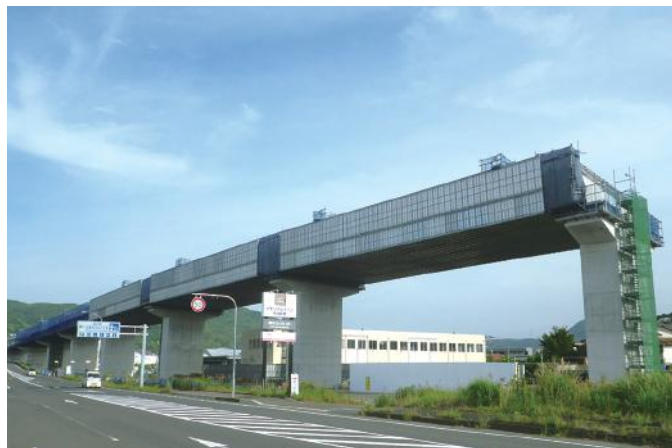
▲ パネル式吊り足場
