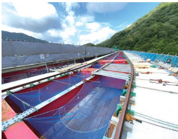
▲ 架橋地点 (R=400m) に対応した軌条配置
