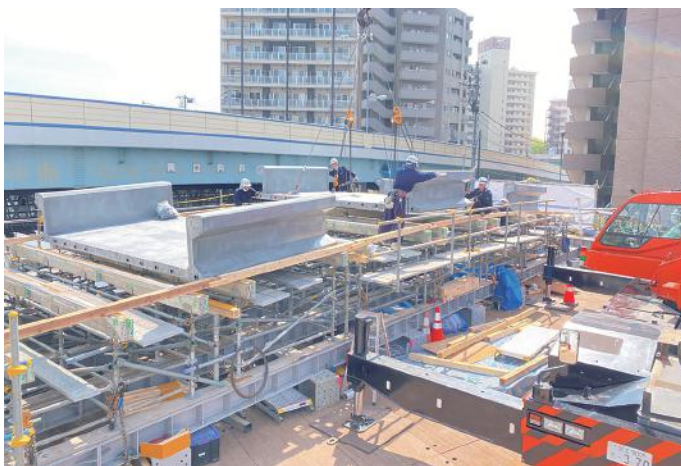
▲セグメント架設状況
