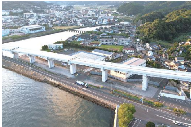
▲ 完成写真(左端がP9橋脚)
