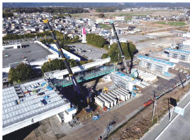
▲ 大型クレーンによる架設状況
