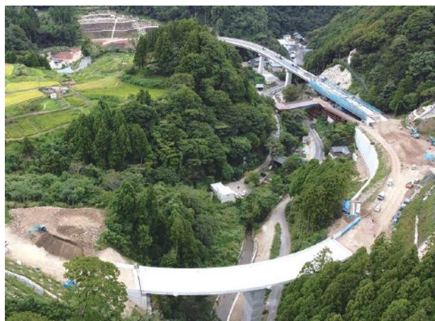
▲ 一般国道365号梅浦バイパス全景
