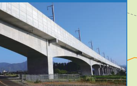
浅水川橋りょう (p.4)
