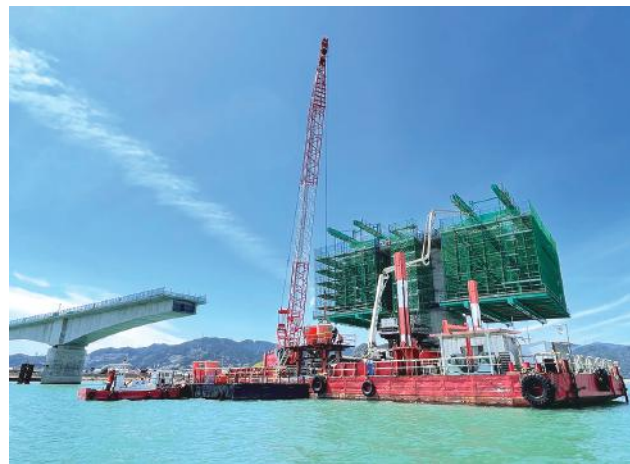
▲ 施工状況 生コンクリート打設状況
