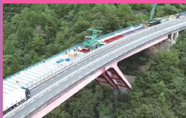
容谷橋他1橋 床版取替工事 (p.40)
