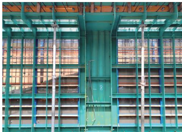
▲ 透明型枠を使用したコンクリート打設
