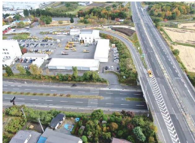
▲ 仮ランプ造成状況
