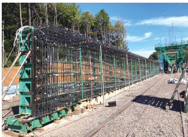
▲ 施工ヤードでの主桁製作状況
