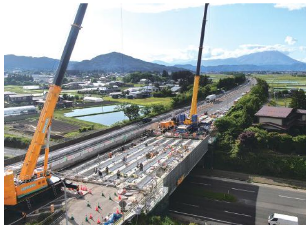
▲ 床版解体状況
