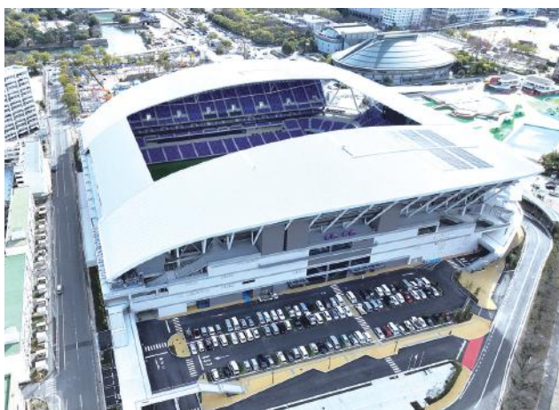
▲ 旧太田川からの外観
