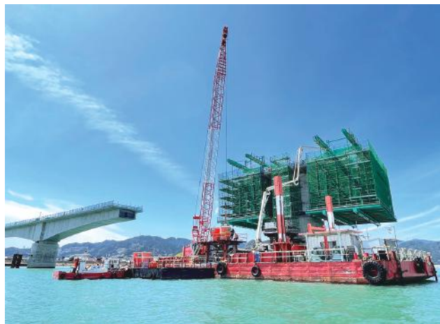
▲ 施工状況 生コンクリート打設状況
