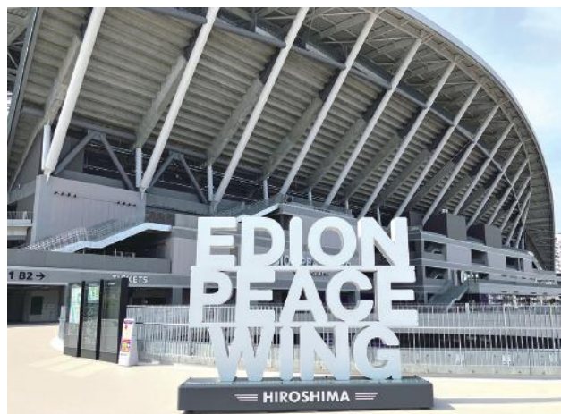
▲ メインゲート付近のモニュメントとPC段床板裏側
