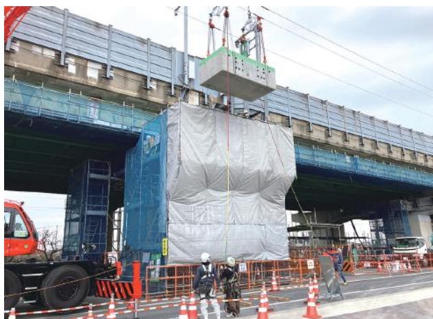
▲ プレキャスト拡幅梁架設状況
