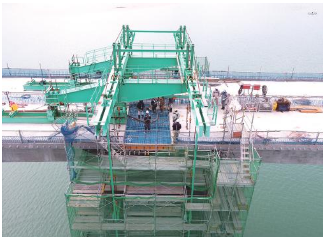
▲ 施工状況 中央閉合部
