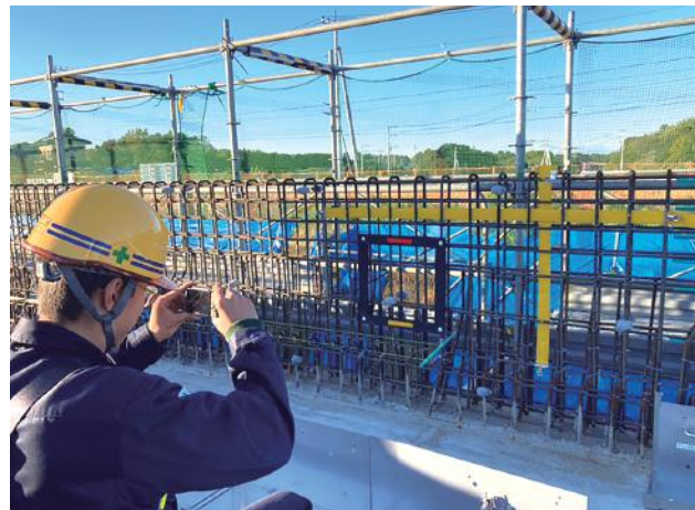
▲ 配筋状態撮影
