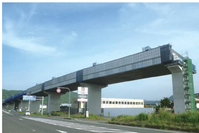
▲ パネル式吊り足場
