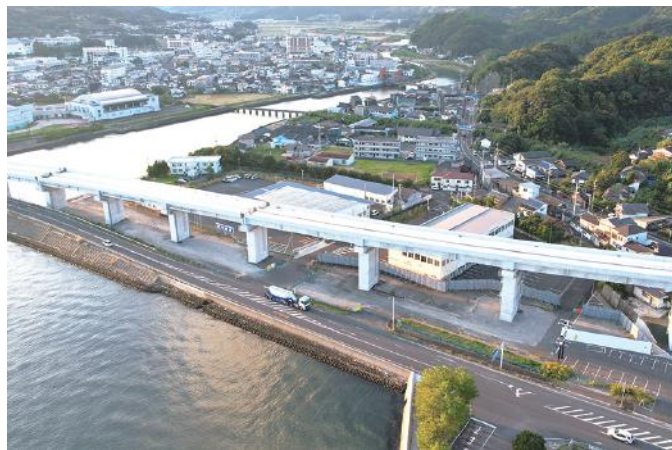
▲ 完成写真(左端がP9橋脚)
