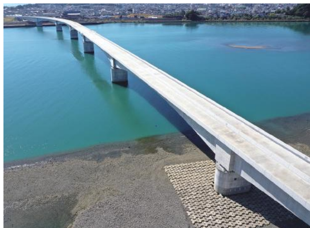
▲ 完成写真 三重県側から
