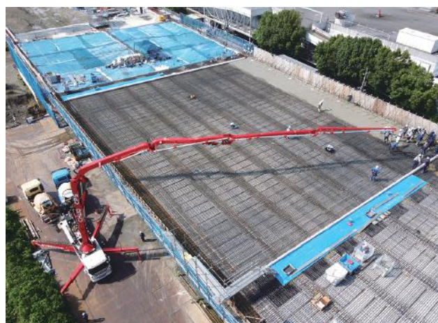
▲ 超ロングブームのポンプ車による床版打設状況
