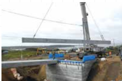
▲ クレーン架設(プレテンション桁)
