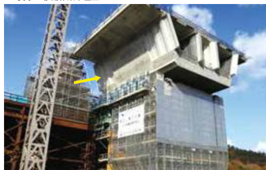
▲ 写真-5 柱頭部押し出し架設
