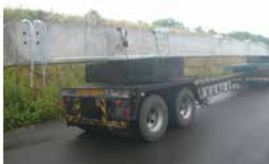
▲ プレテンション桁の運搬
