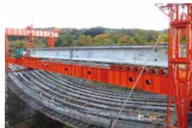
▲ 架設桁架設(ポストテンション桁)
