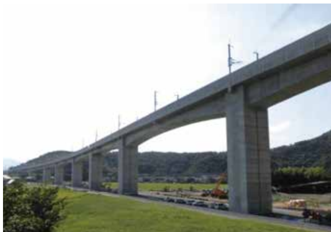
▲写真-4 大蔵余座橋りょう
