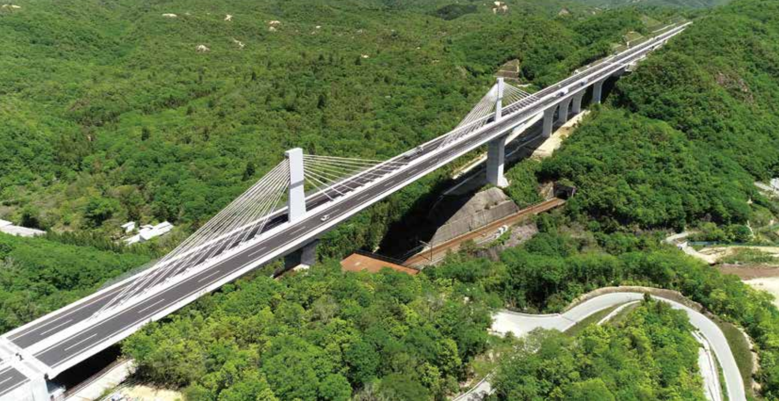
▲写真-1 生野大橋全景
