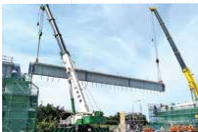
▲ クレーン架設(ポストテンション桁)
