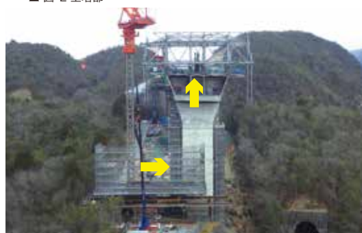
▲ 写真-4 移動作業車組立て
