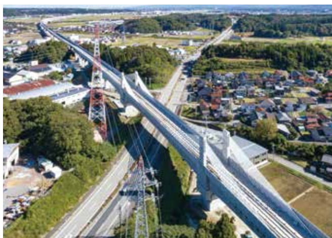
▲ 写真-2 加賀細坪橋りょう
