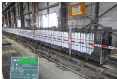
▲ プレテンション桁の製作状況
