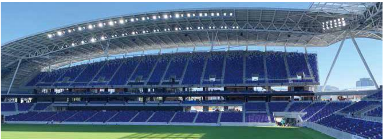
▲ 写真-1 スタジアム内観
