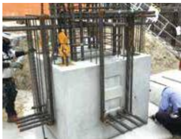
基礎フーチング
