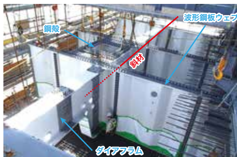
▲ 写真-2 斜材定着構造
