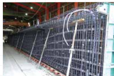
▲ ポストテンション桁の製作状況
