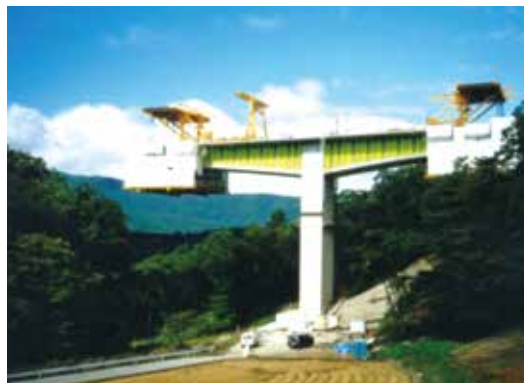
▲ 写真-2 張出し架設状況
