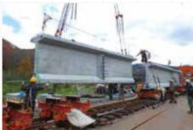
▲ ポストテンション桁(セグメント)の接合
