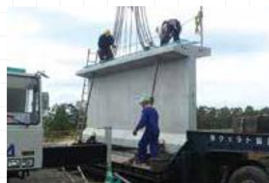
▲ ポストテンション桁(セグメント)の運搬
