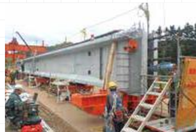
▲ ポストテンション桁(セグメント)の緊張
