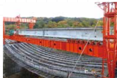
▲ 架設桁架設(ポストテンション桁)
