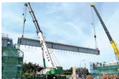
▲ クレーン架設(ポストテンション桁)
