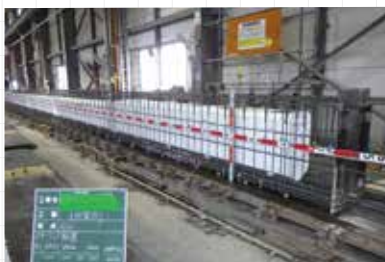
▲ プレテンション桁の製作状況
