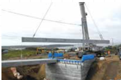
▲ クレーン架設(プレテンション桁)
