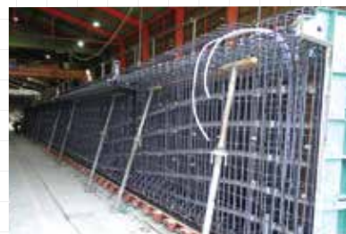
▲ ポストテンション桁の製作状況
