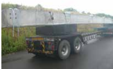
▲ プレテンション桁の運搬
