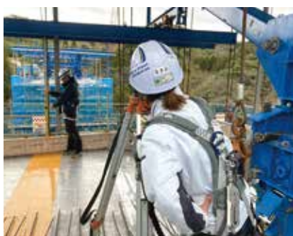
▲ 現場での作業
