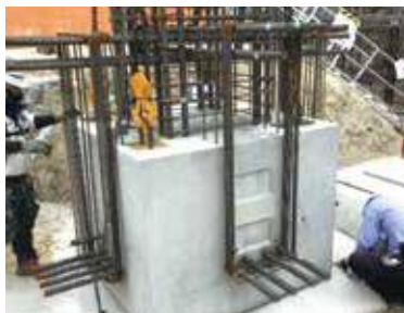
基礎フーチング
