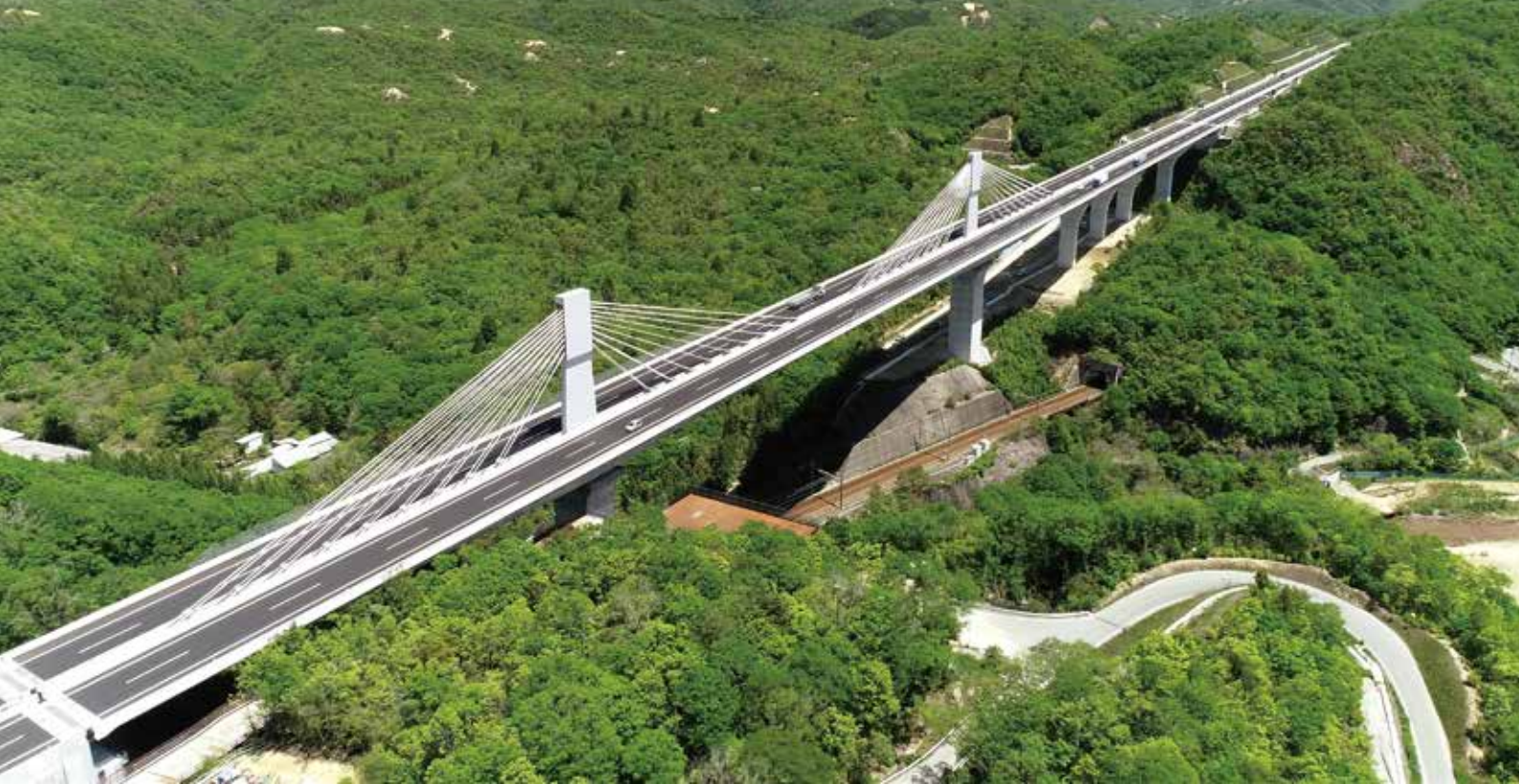
▲写真-1 生野大橋全景
