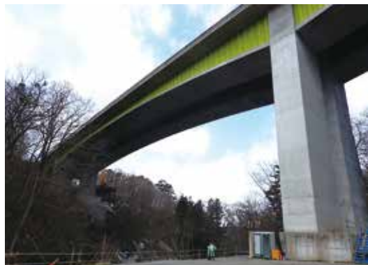
▲ 写真-3 現在の本谷橋(手前が1期線)
