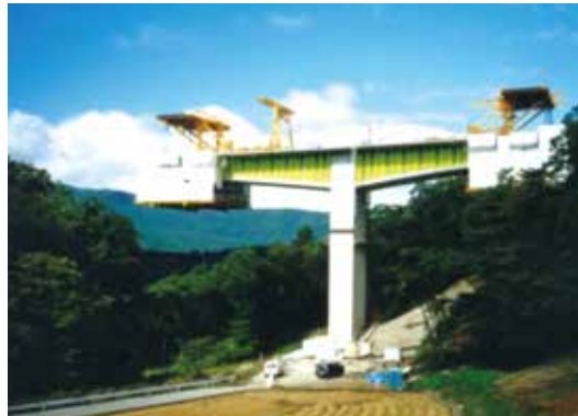
▲ 写真-2 張出し架設状況
