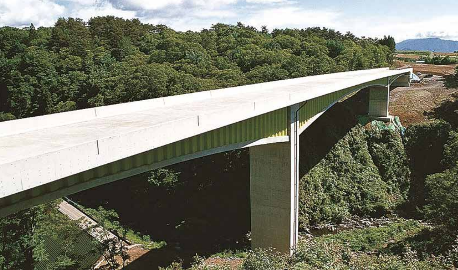
▲写真-1 完成写真(完成当時)
