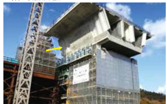
▲写真-5 柱頭部押し架設
