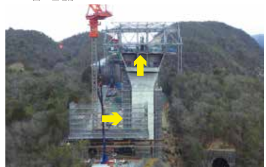
▲写真-4 移動作業車組立て
