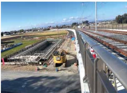
▲ 鬼怒川右岸から西方面全景。新たな軌道と道路整備、それに伴う雨水流出を抑制するための調整池の整備
