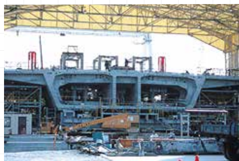
▲ 橋梁架設地点付近での製作
