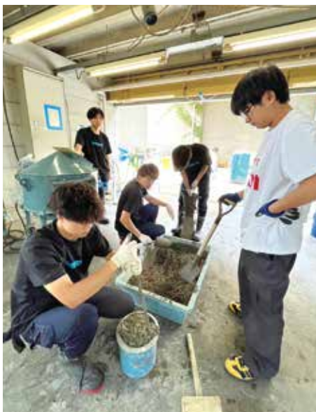
◀ コンクリート打設中
