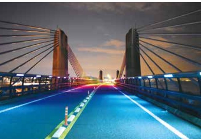
▲写真-5 西湘バイパス開通50周年(令和4年)特別照明時
