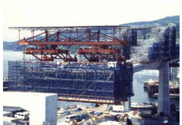
▲写真-4 施工時(張出し中)の写真(写真提供:春日昭夫)
