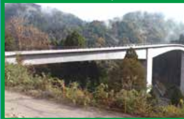
足羽川ダム 付替県道11号橋 (p.24)
