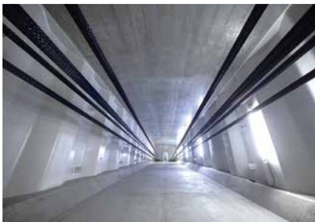
▲ 橋梁内部完成状況:橋梁内部の波形鋼板と橋を支えるPC鋼材
