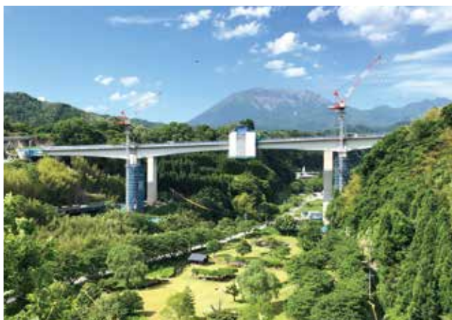
▲ 中央閉合施工状況:新緑の頃、主桁の完成まで間もなく
