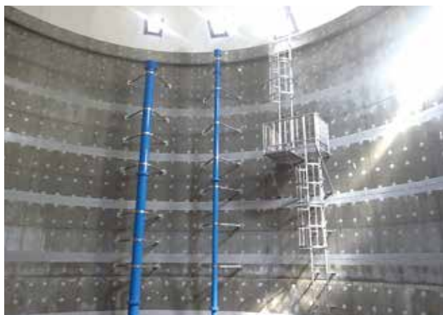
▲ 配水池内部無塗装
