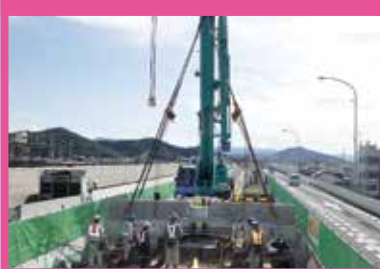
松島高架橋桁取替工事 (p.36)
