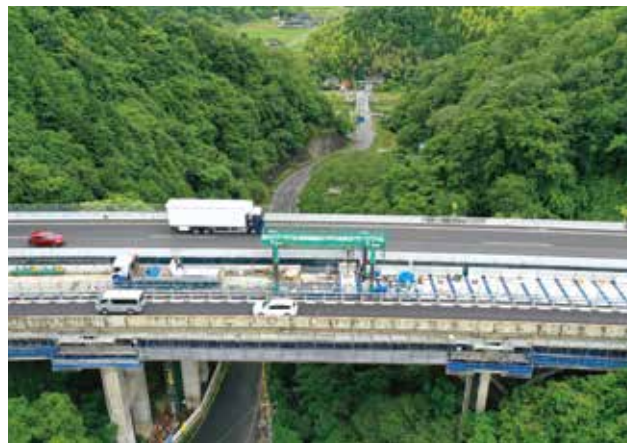
▲プレキャストPC床版架設状況全景
