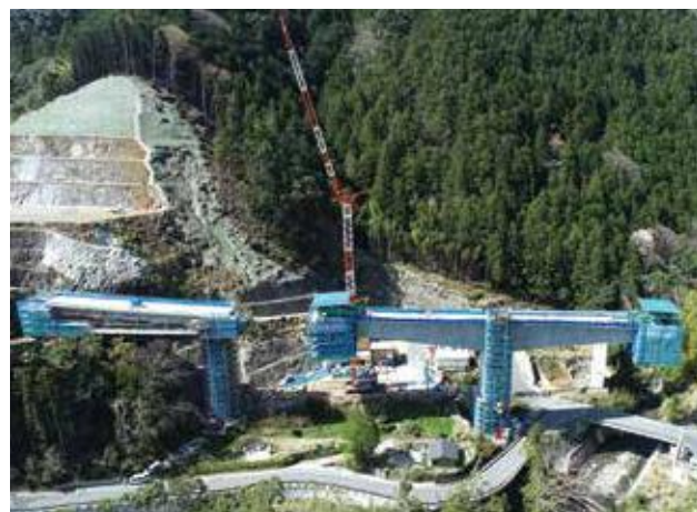
▲ 左:固定支保工架設 右:片持架設
