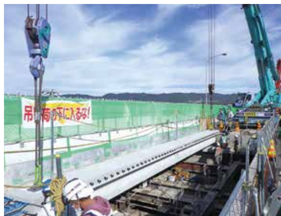
▲ SCBR工法によるプレテンションPCT桁へ架替
