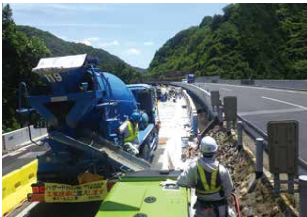
▲定置式ポンプによるコンクリート打ち込み状況
