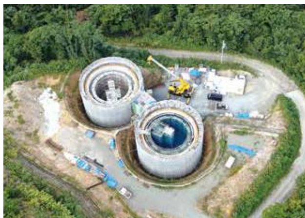
▲ 水張り試験状況(8月)
