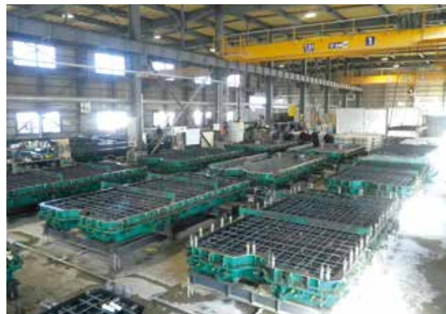
▲ 軌道スラブ製作状況
