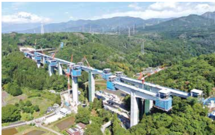
▲ 移動作業車による片持架設
