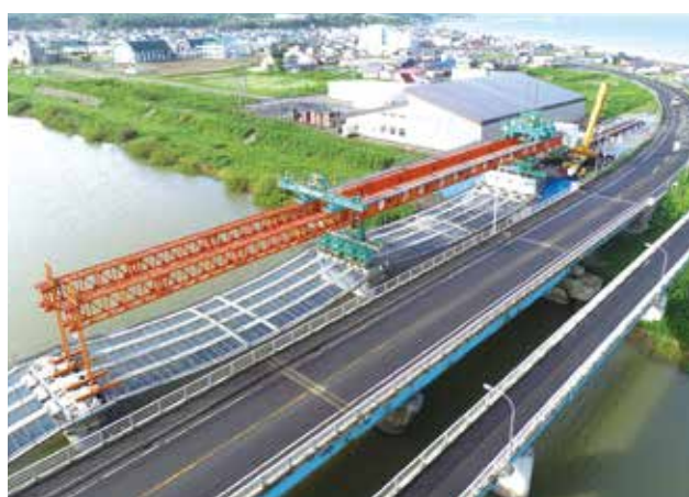
▲ 二組架設桁による架設状況(全景)
