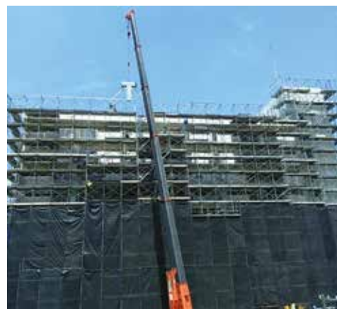
▲柱部材架設状況
