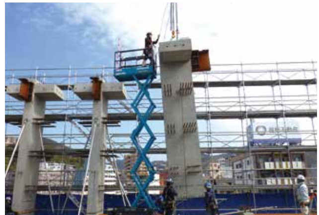
▲ プレキャスト部材の架設
