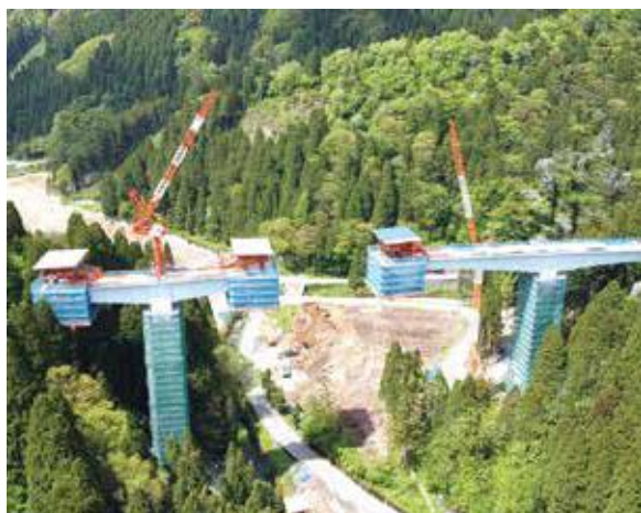
▲ 片持架設施工中
