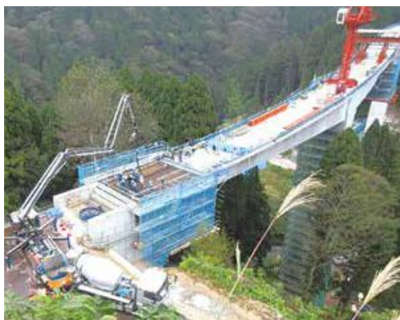
▲ 側径間施工中
