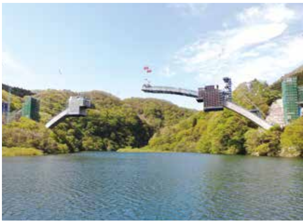
▲初夏:鋼メラン材架設
