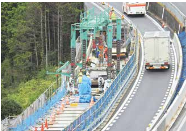
▲プレキャストPC床版架設状況
