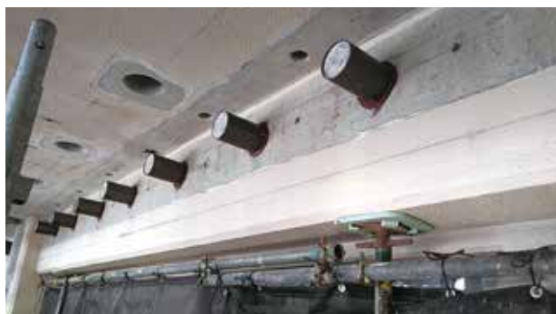
▲鋼管コッター取り付け状況
