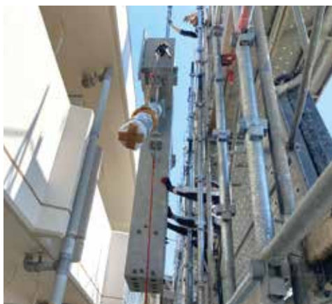
▲柱部材架設状況 近景
