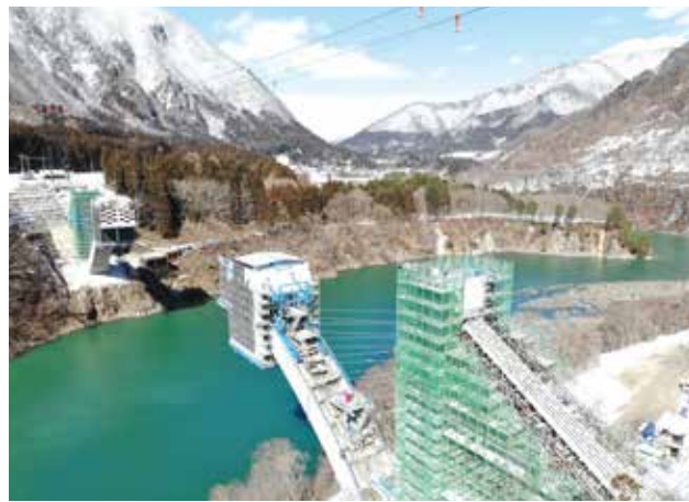
▲冬:アーチリブ斜吊り張出し施工
