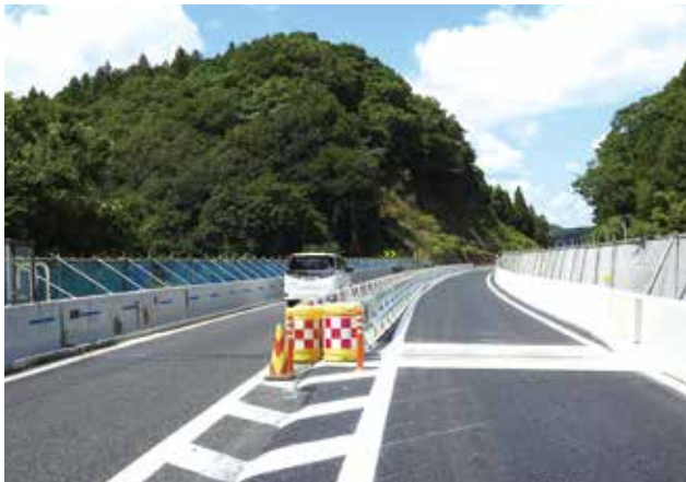
▲仮設防護柵設置状況
