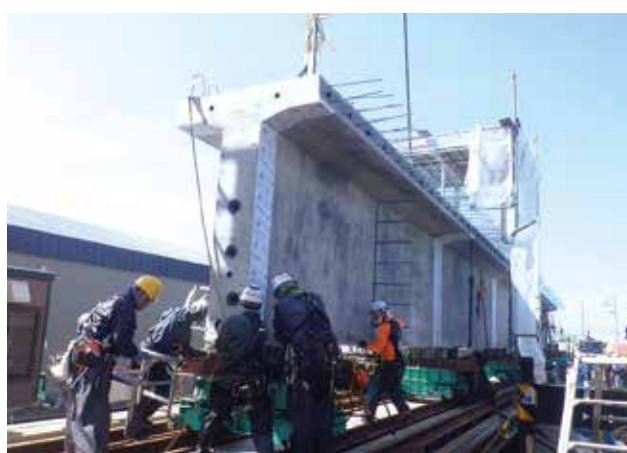
▲ セグメント桁組立状況
