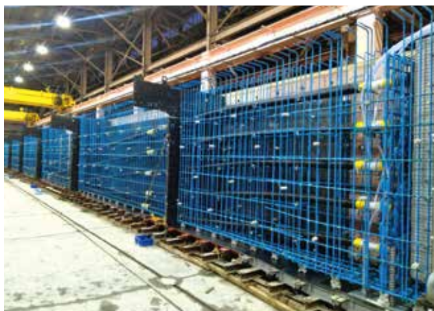
▲ セグメント桁工場製作状況
