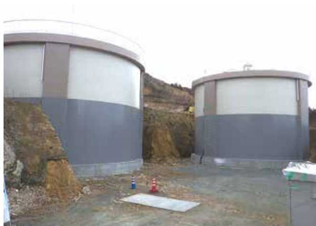
▲ 配水池廻り埋戻し前
