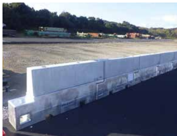
▲ ハイブリッドスリムガード仮組状況
