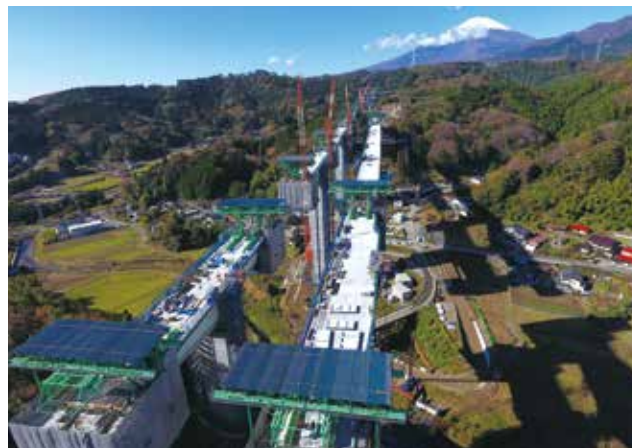
▲ 大型移動作業車12基による施工状況
