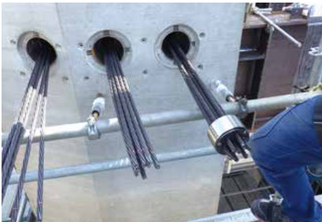
▲ PC鋼材の配線(緊張端)
