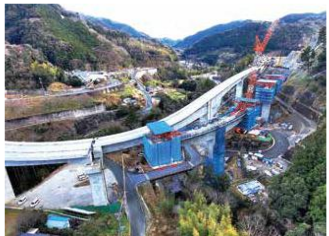
▲ 移動作業車によるBランプ橋の施工(奥がAランプ橋)
