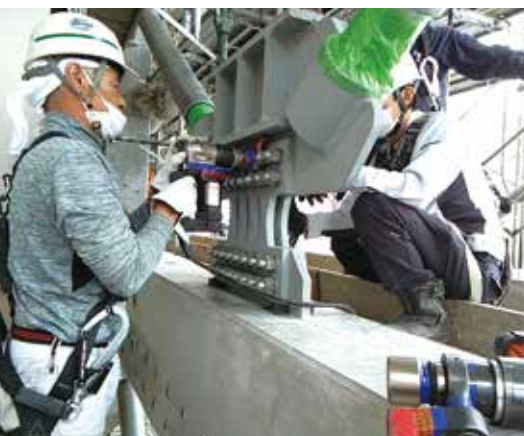
▲ダイヤ型スリットダンパ取り付け状況
