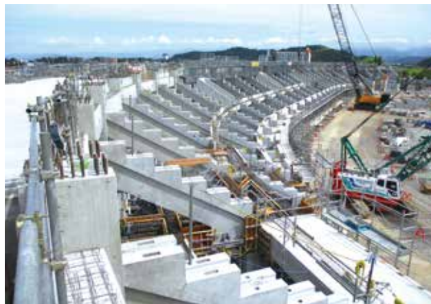
▲メインスタンドPC部材架設状況
