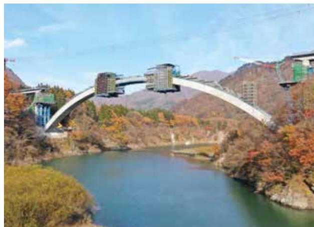
▲秋:アーチリブコンクリート巻き立て施工状況
