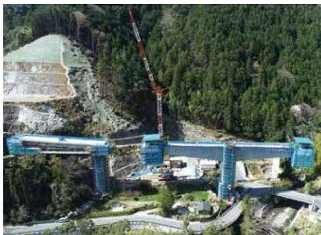
▲ 左:固定支保工架設 右:片持架設
