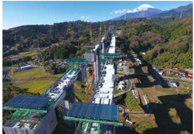
▲ 大型移動作業車12基による施工状況
