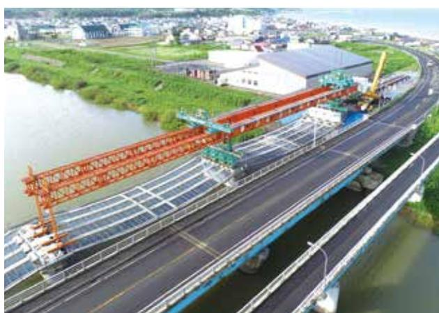
▲二組架設桁による架設状況(全景)
