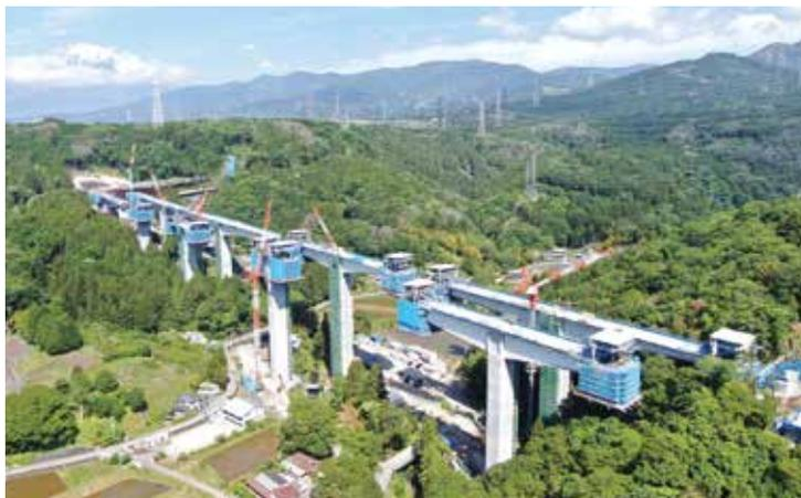
▲ 移動作業車による片持架設
