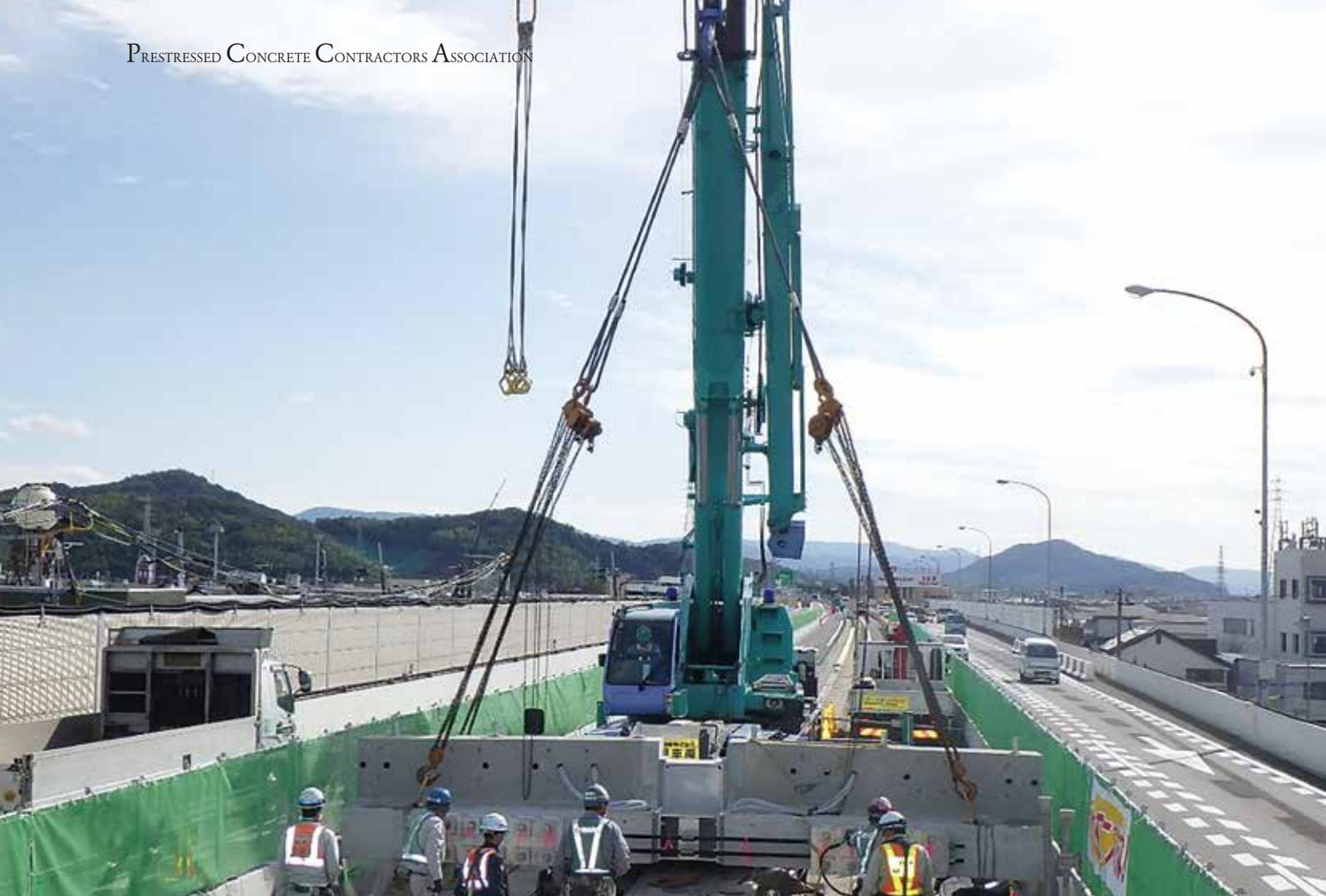
ことで曲線にも対応でき、一般走行車両の逸脱防止と工事作業員の安全を確保することができました。
