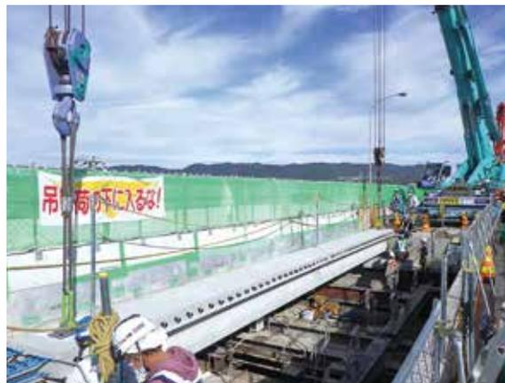
▲SCBR工法によるプレテンションPCT桁へ架替
