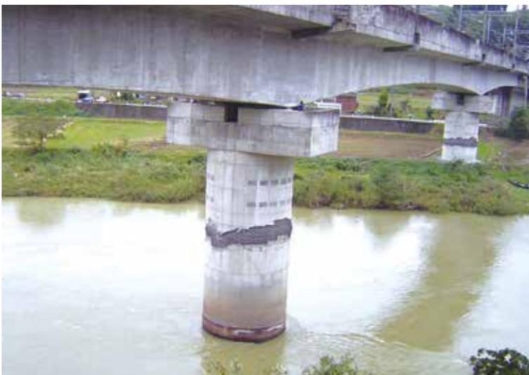
▶新潟県中越地震において被災した上越新幹線魚野川橋梁(かぶりコンクリートが一部剥落したが橋脚の軸力保持機能は保たれ、軌道は元の位置を保っていた)。(提供：下村匠氏)
