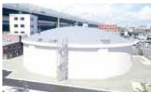
09. 上馬伏4号配水池
