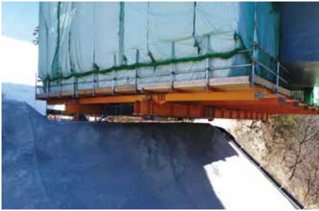
▲ 移動作業車通過状況
