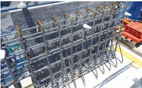
▲ 壁高欄埋設型枠の使用
