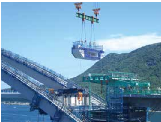
▲接合桁架設状況
