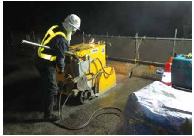
▲既設床版切断状況
