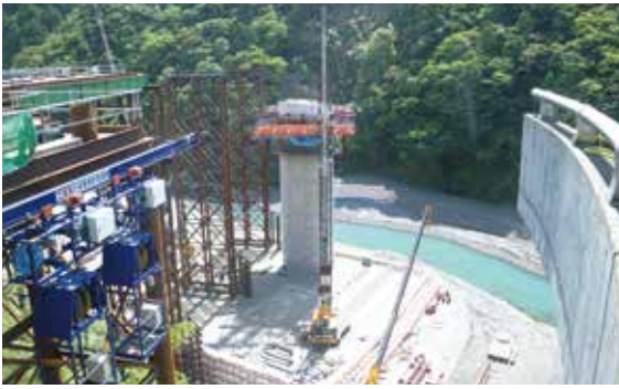
▲ 橋脚と仮橋の同時施工
