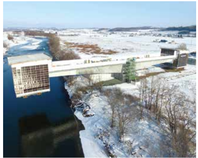
▲ 厳冬期の片持架設状況
