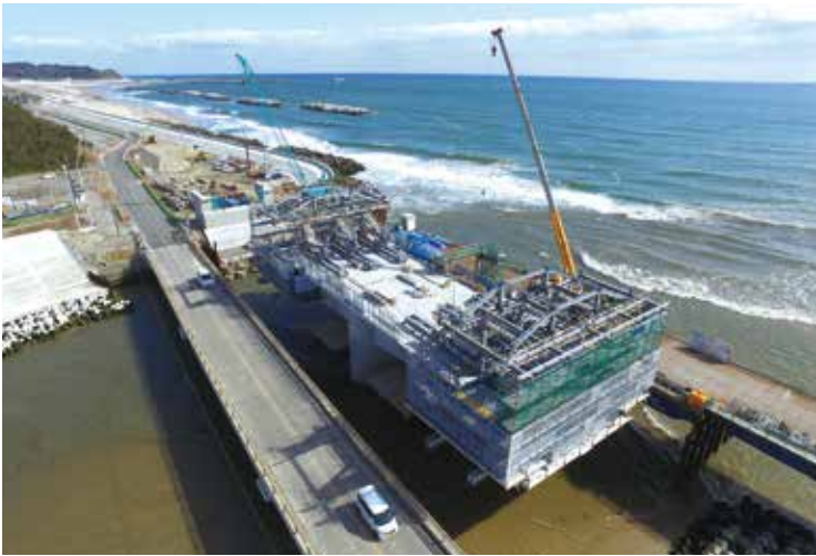
▲ 架設状況全景(左は架け替え前の橋)
