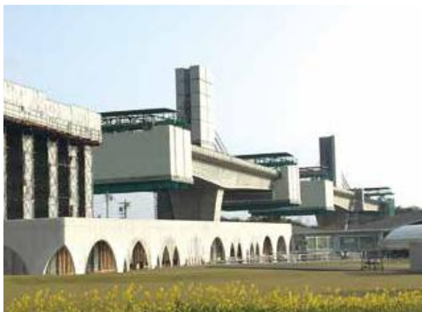
▲片持架設状況(防護パネル使用)
