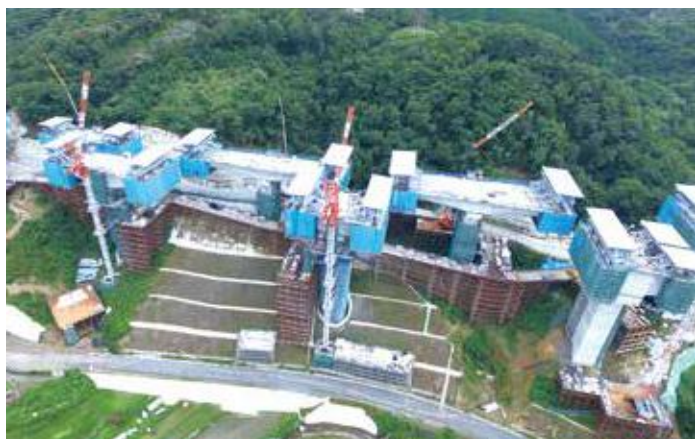
▲ 最盛期の片持架設状況②
