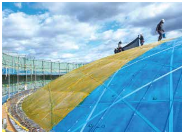
▲プライマー塗布
