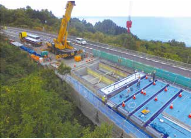
▲プレキャストPC床版架設状況
