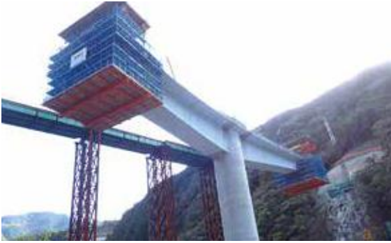
▲ 片持架設状況
