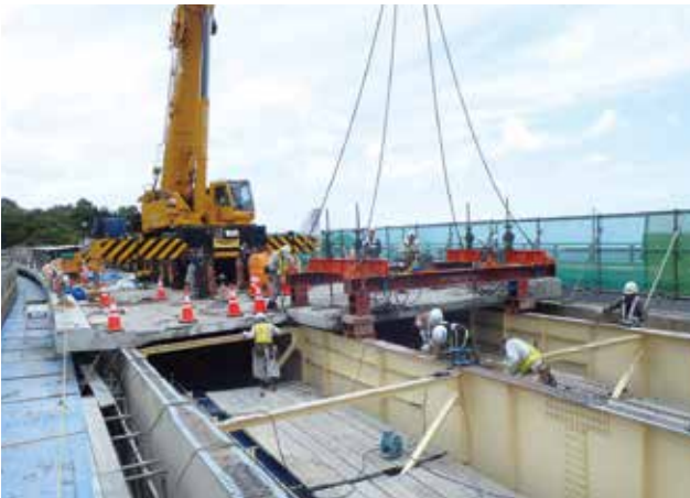
▲既設床版撤去状況
