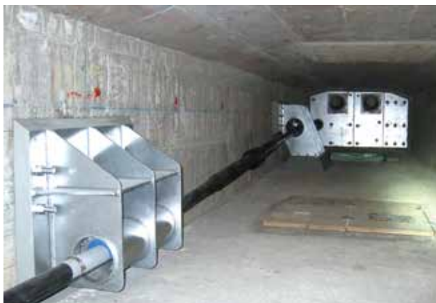
▲ 箱桁内外ケーブル補強
