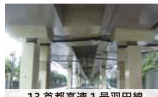
13. 首都高速1号羽田線 (勝島地区)補強工事
