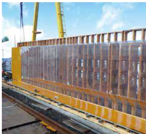
▲ PC桁製作用の透明型枠
