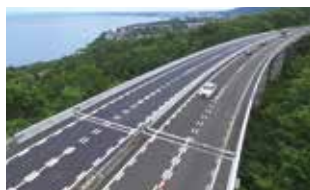
12. 大野橋床版取替工事
