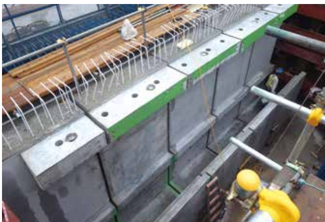
▲パラペット部材の接合
