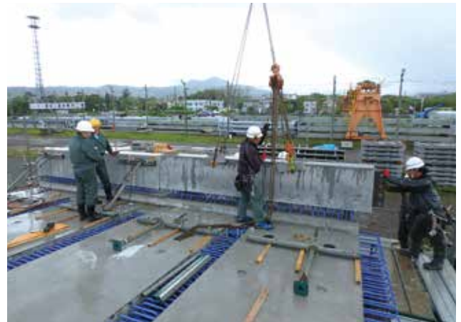
▲実物大試験、DAK式プレキャスト壁高欄架設状況
