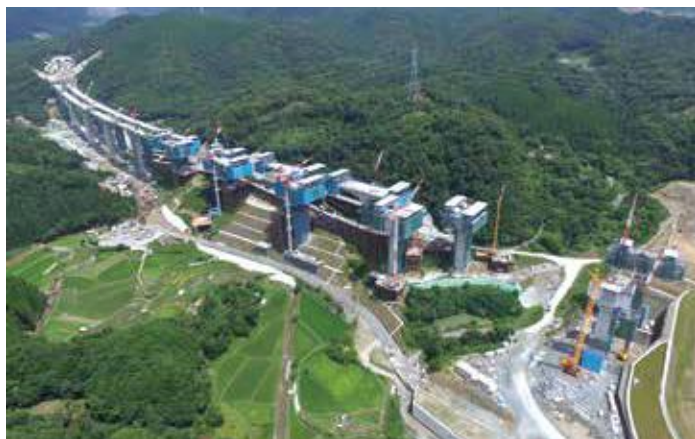
▲ 最盛期の片持架設状況①
