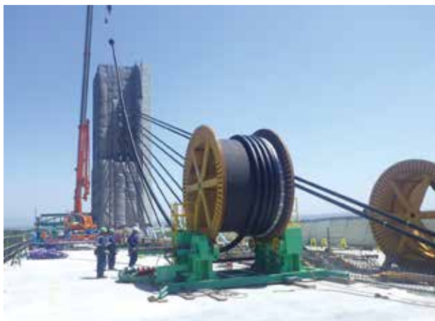
▲セミプレファブ斜材ケーブル架設
