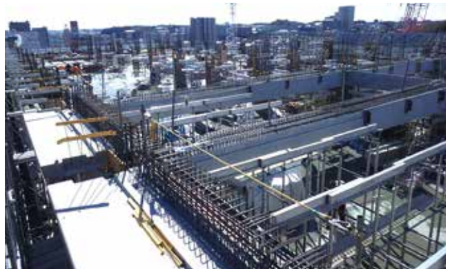
▲ 現場施工状況
