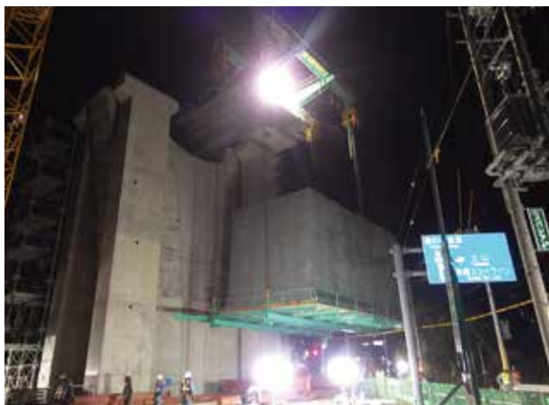
▲国道近接部作業車組立
