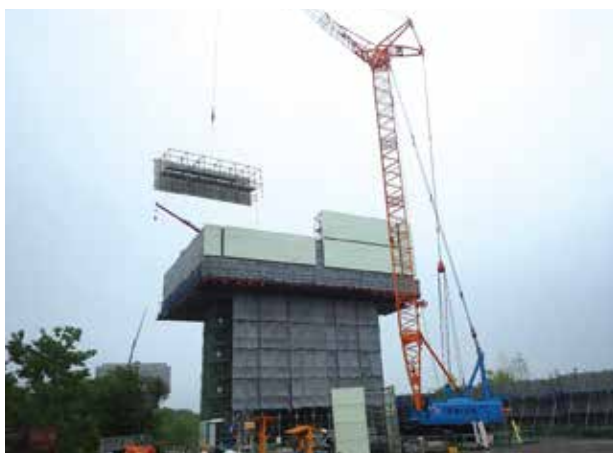
▲柱頭部支保工組立(ユニット化)
