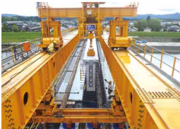
▲ PC桁の架設状況
