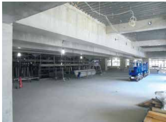
▲ PCで一体化された梁
