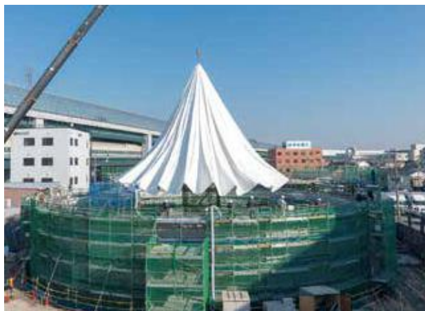
▲シート膜設置状況
