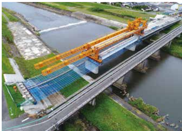
▲ 二組桁架設装置
