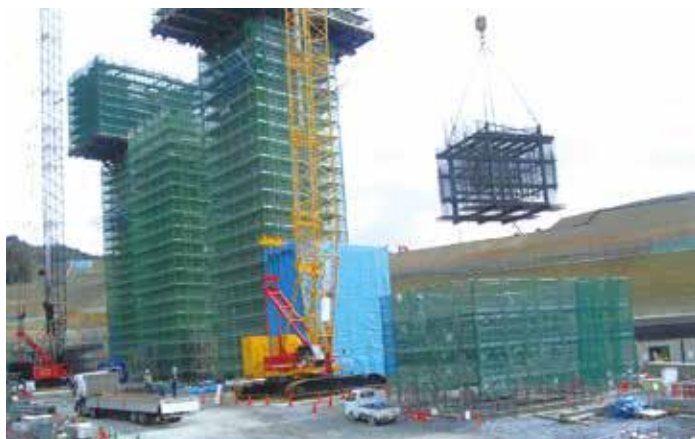
▲ プレファブ鉄筋架設状況
