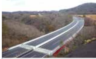
14. 本村川橋床版取替工事
