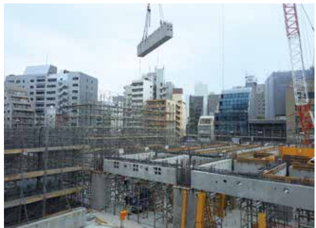
▲ プレキャスト部材の架設状況
