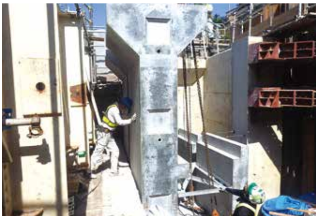
▲パラペット部材の設置状況
