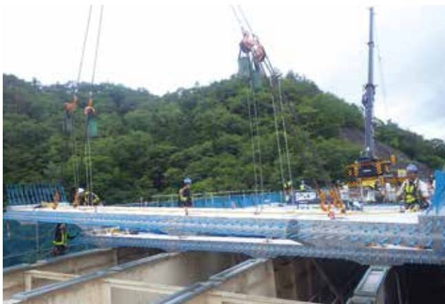
▲プレキャストPC床版架設状況
