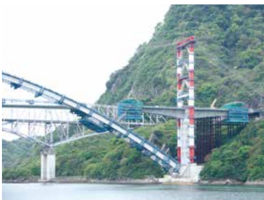
▲片持架設状況
