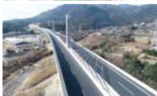
04. 菰野第二高架橋
