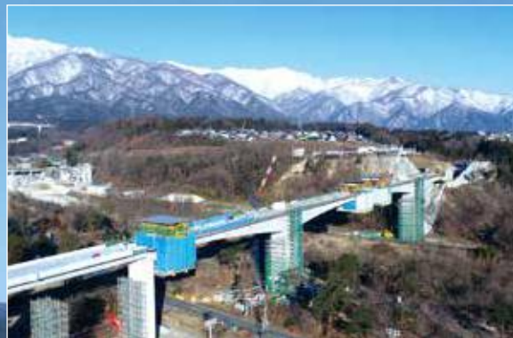
▲片持架設状況(中央アルプスを望む)
