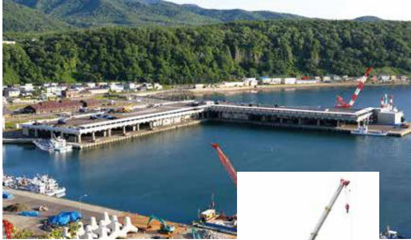
▲ウトロ漁港の人工地盤 珍しい2階建ての漁港は、安全面や衛生面からPCの人工地盤が採用された。面積は1万7000㎡、大きさは縦176m、横204m、高さ10m。
