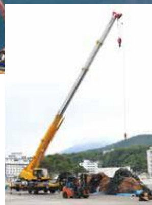
▶長さ2kmの定置網は、人工地盤上でクレーンで釣り上げて補修を行う
