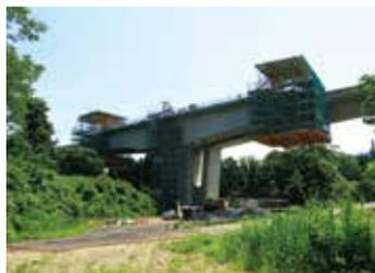
▲ 移動作業車による施工
