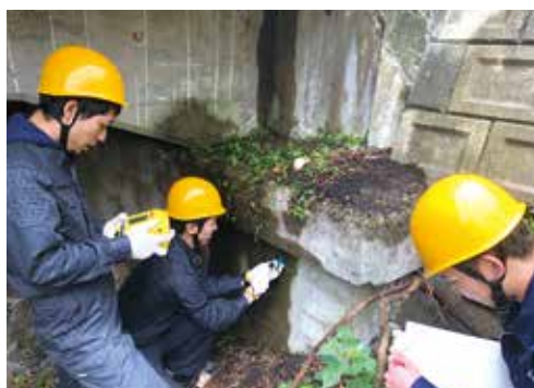
実橋梁でのコンクリート物性値の測定
