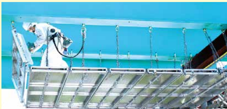
▲ パネル式吊棚足場
