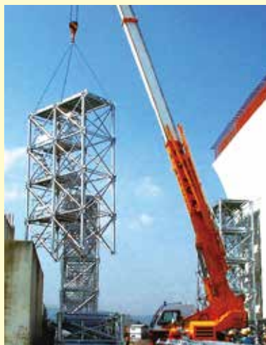
▲ ユニット支保工をクレーンで吊上げて架設
