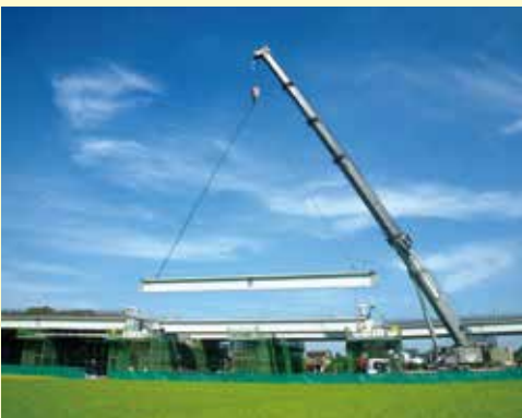
▲ プレキャスト桁の活用（埼玉県・川田谷高架橋）
