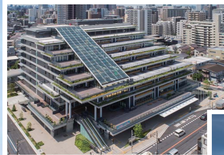
川口市新庁舎1期棟
