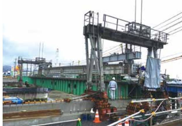
▲ ジャッキアップ横取り装置による主リヘンの架設
