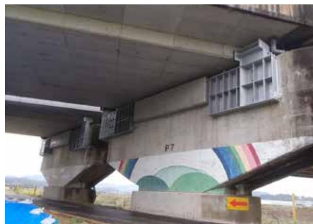
▲水平力分担構造鋼製ブラケット
