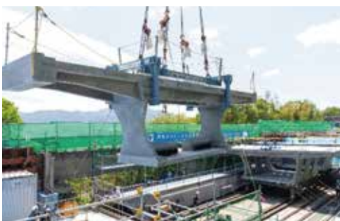
▲ 徳島自動車道 別荘谷橋
