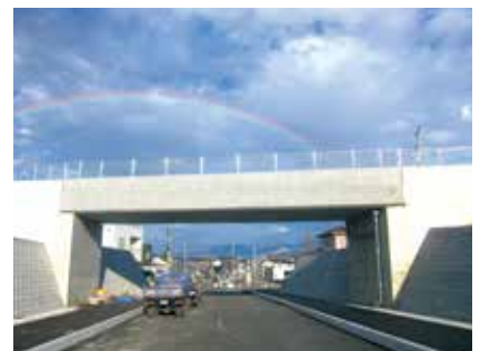
▲ 初めて現場所長として施工したPC橋梁
