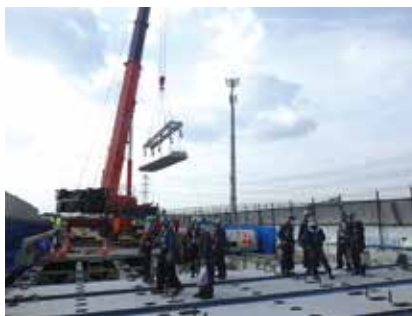
▲ PC床版取替状況
