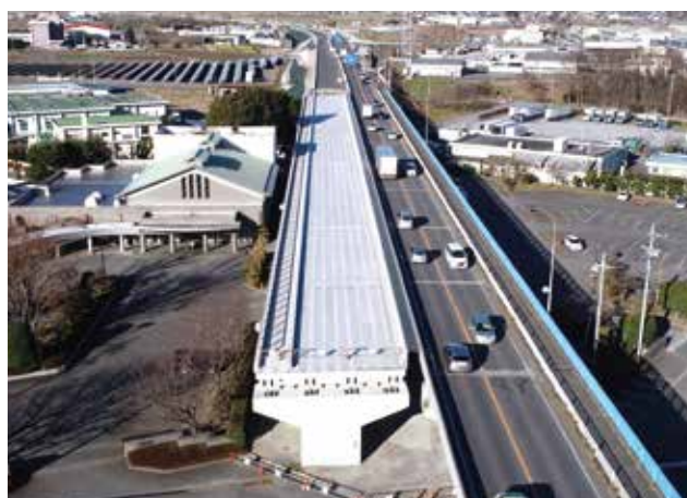
▲ 公共施設が隣接する狭い空間での施工
