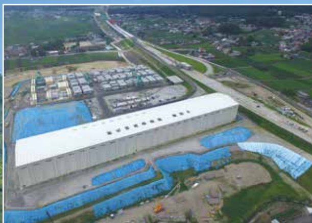
▲セグメント製作ヤード
