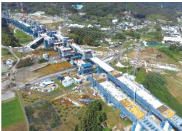
▲ 施工状況全景
