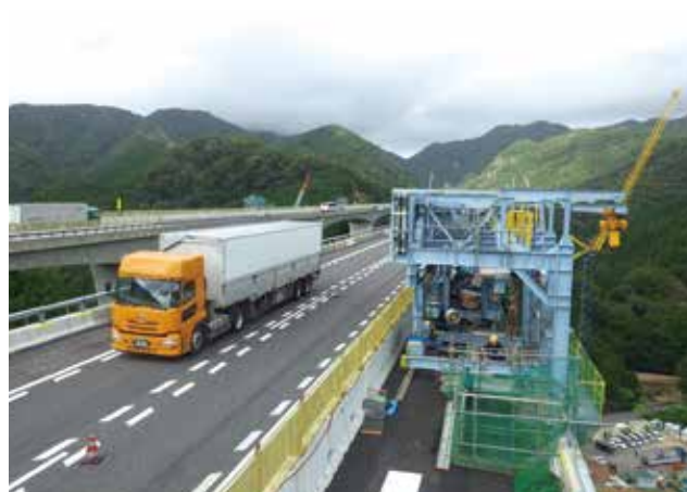
▲ 供用中の高速道路での施工
