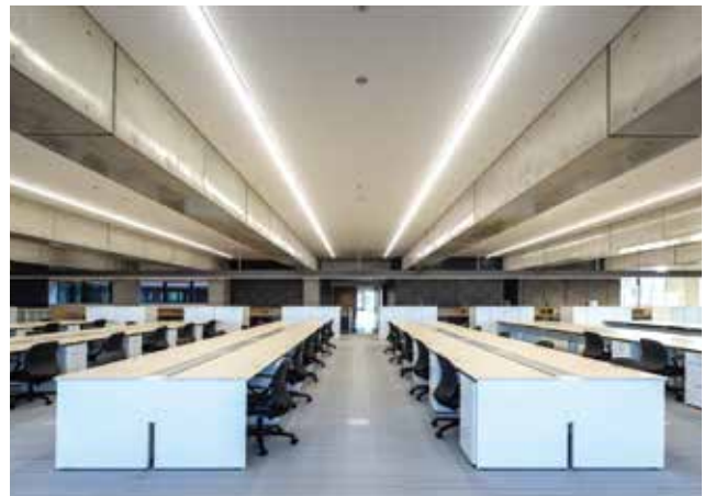
▲ 南北方向に架けた均質なPC梁
