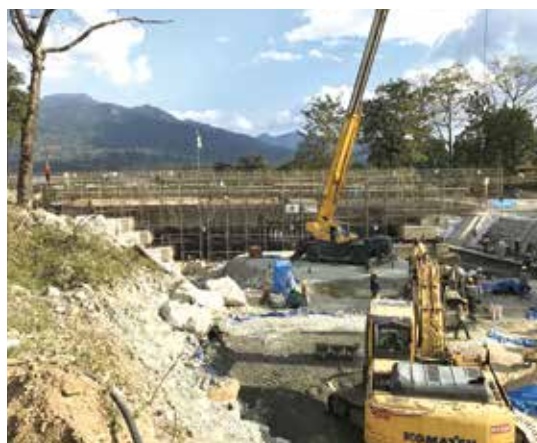
▲時間の限られた乾季中に集中して施工しました
