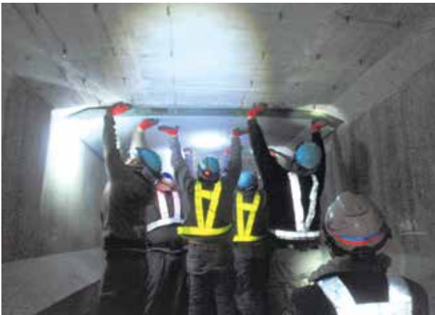
▲ 鋼板接着状況
