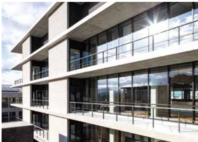
▲ 南面の日射負荷抑制と窓面のメンテナンス用とした庇(アンボンドPCスラブ)
