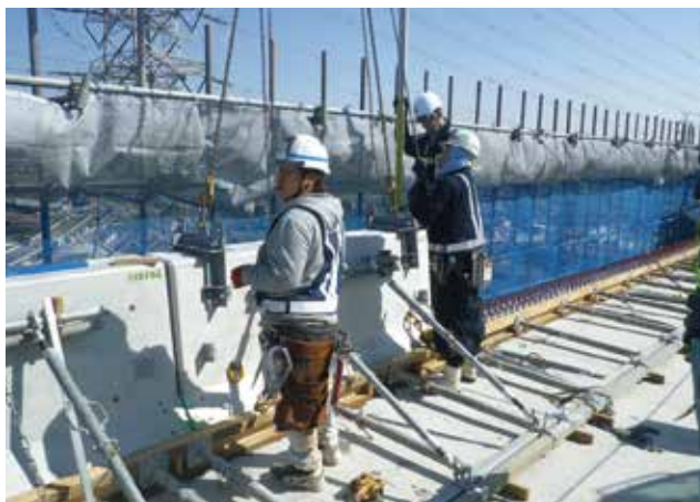
▲ プレキャスト壁高欄架設状況
