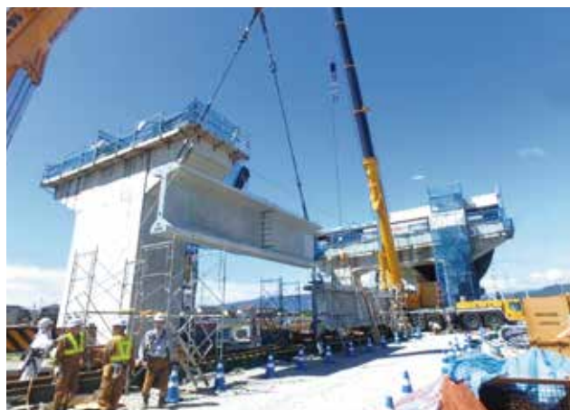
▲ プレキャストセグメント桁の組立
