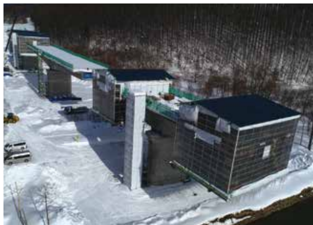
▲ 寒中施工の状況
