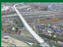
矢賀跨線橋 (p.08)
