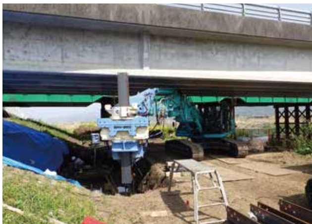
▲ 桁下制限下での作業状況
