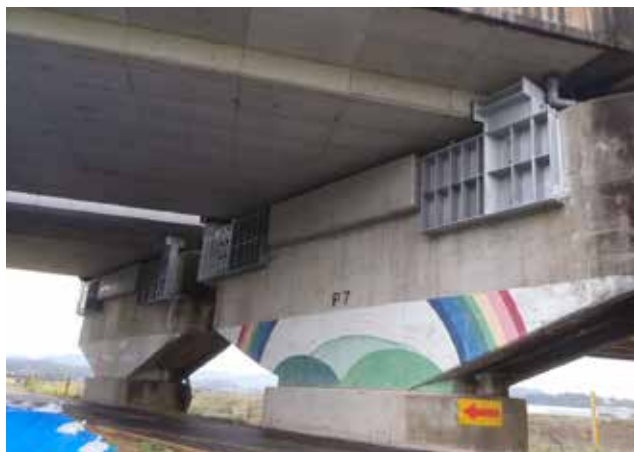
▲ 水平力分担構造鋼製ブラケット
