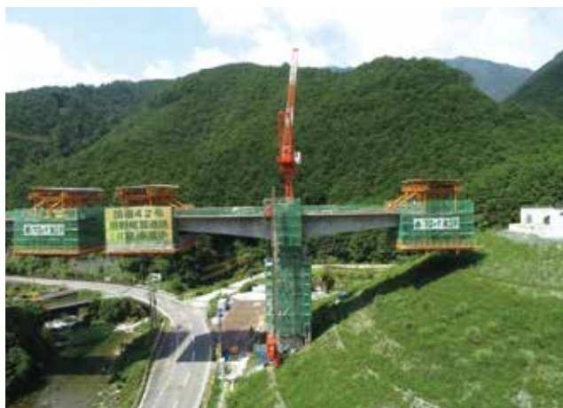
▲ 片持架設状況
