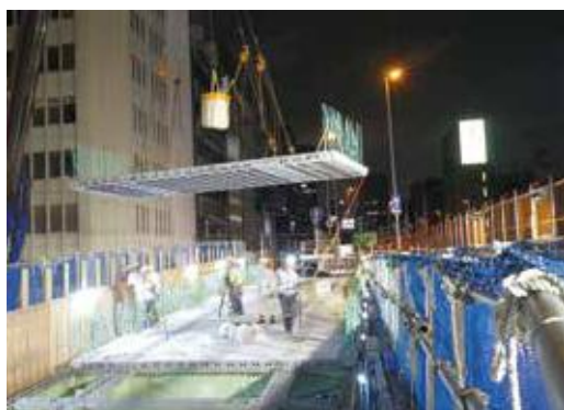
▲ 床版パネルの架設
