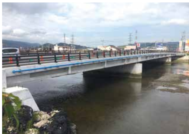
▲ 桁高を抑えたパイプ桁橋
