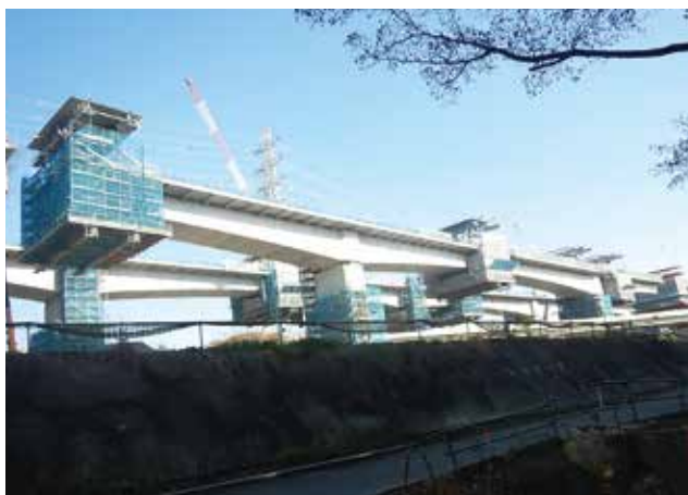
▲ 片持架設状況
