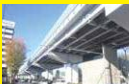
東大阪線 PC 桁大規模修繕工事 (p.34)
