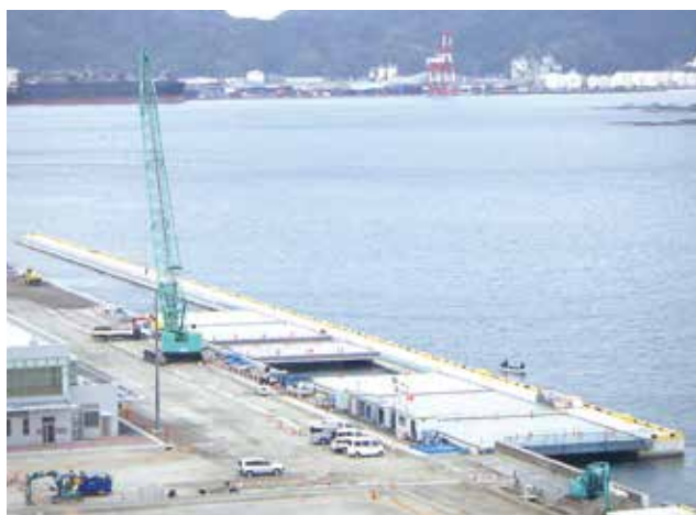
▲ 主桁架設状況
