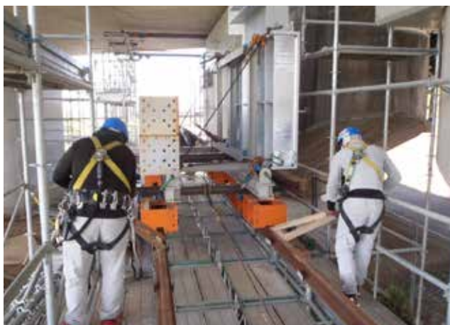
▲ 移動台車でブラケット移動
