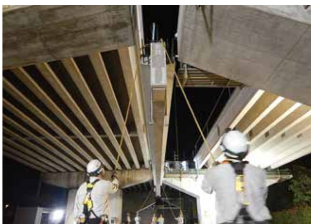
▲ PC桁吊上げ状況(夜間架設)
