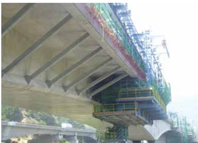
▲ 特殊施工台車での施工
