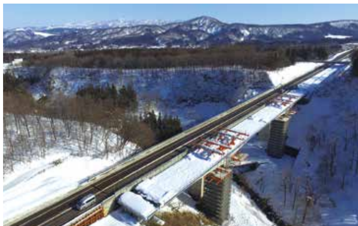
▲ 冬期休工中は移動作業車を柱頭部に退避させた
