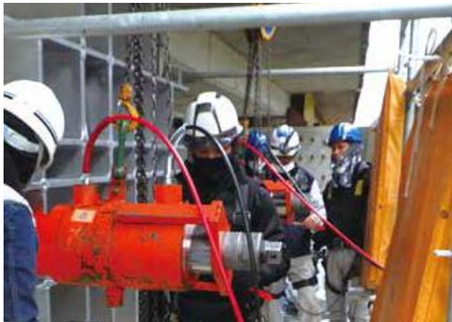
▲ 外ケーブル緊張状況
