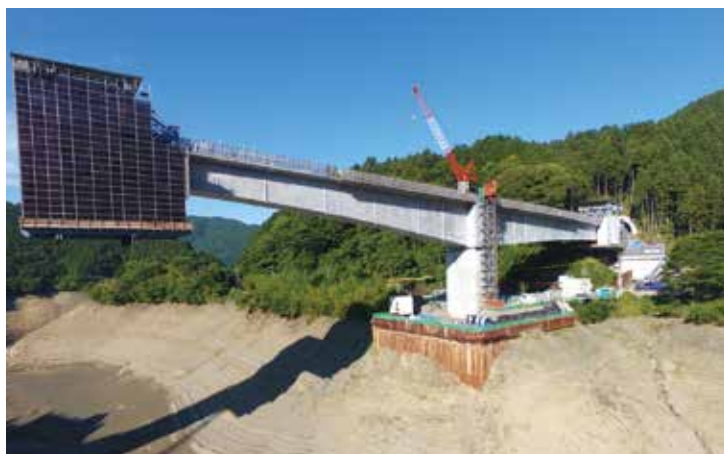
▲ 片持架設状況
