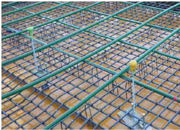
▲ アンボンドPC鋼より線配線状況
