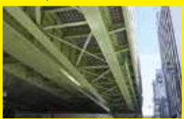
阪神高速信濃橋入路の改築 (p.32)
