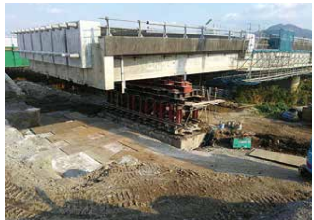
▲ 外ケーブルによる主桁の補強とジャッキアップ後の既設橋台撤去状況
