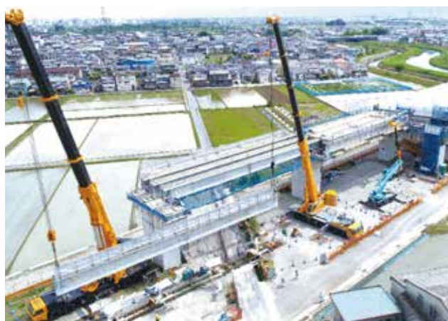
▲ 架設作業写真
