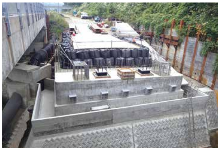
▲ 橋台の周りに水路がある起点側橋台
