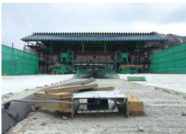
▲ 傾斜計による計測状況 (橋面に設置した傾斜計)
