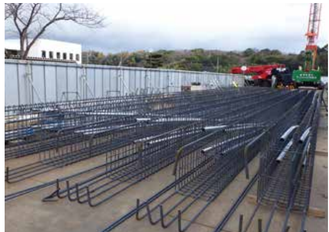
▲ PC梁配筋・シース地組み
