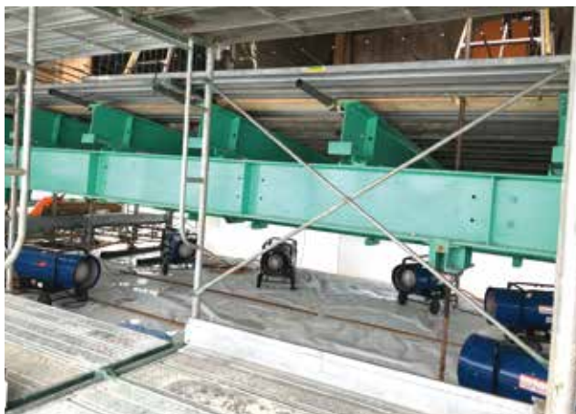
▲ 寒中施工の状況 (給熱養生)
