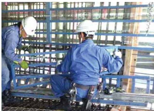
▲ 透明型枠使用状況
