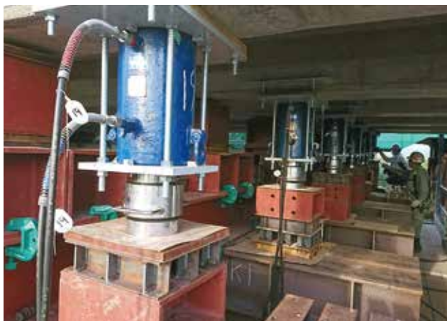
▲ 上部工のジャッキアップ状況
