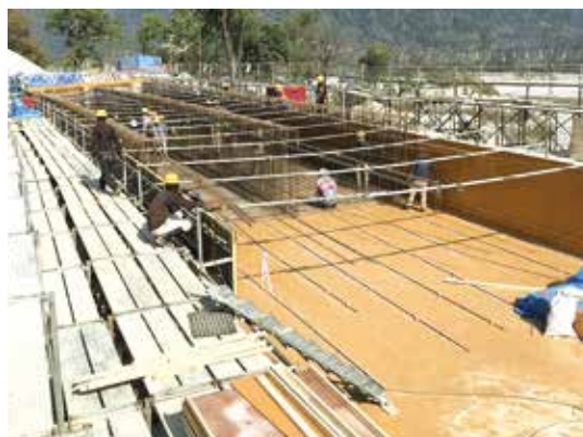
▲上部工下床版型枠設置と鉄筋組立の様子
