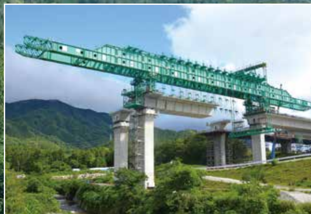
▲スパン・バイ・スパン工法による架設
