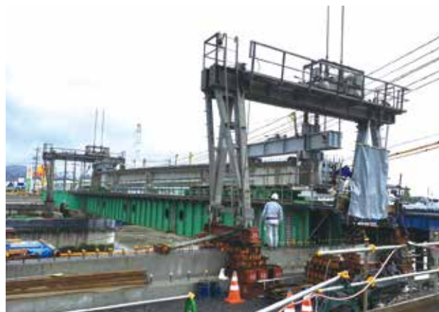
▲ ジャッキアップ横取り装置による主桁の架設
