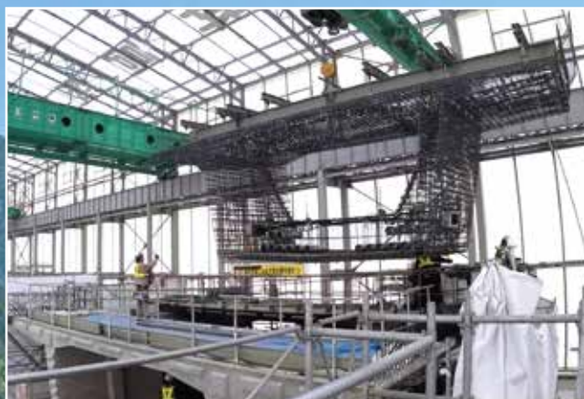
▲ショートラインマッチキャスト工法によるセグメントの製作
