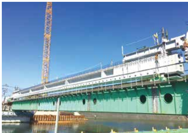
▲ 架設桁上での主桁組立
