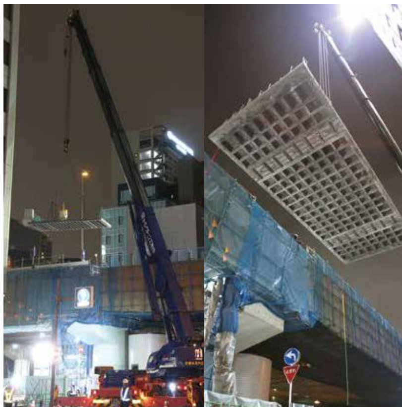
▲ クレーンにより吊り上げられたワッフル型UFC床版
