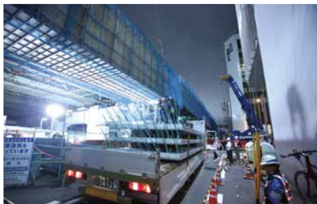
▲トラックによる床版パネルの運搬
