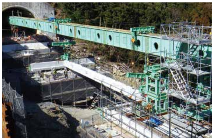
▲ 施工中(SCBR工法を採用)
