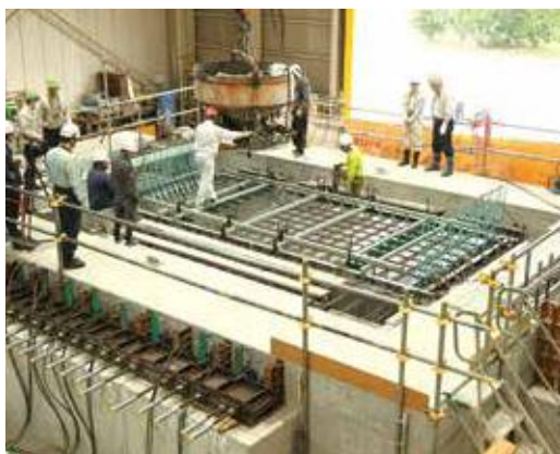
▲ 床版パネルの打設
