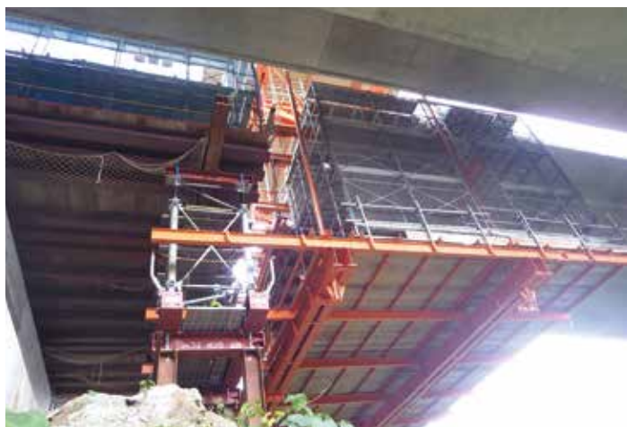
▲ 移動作業車の梁を支保工に入り込ませた側径間閉合状況
