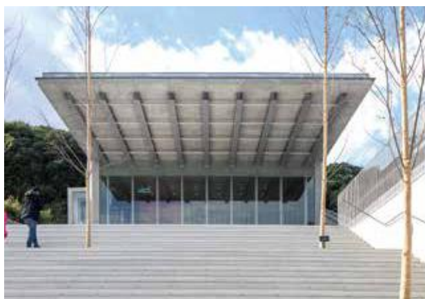
▲ 吊り構造屋根
