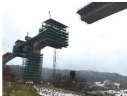
▲ 片持ち架設中の橋梁
