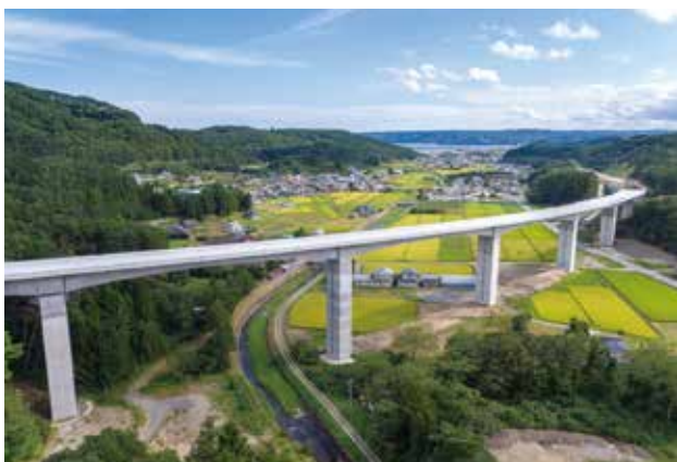
▲ 三陸沿岸道路 夏井高架橋
