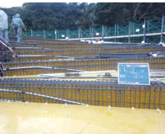
▲ 場所打ち PC 梁の施工
