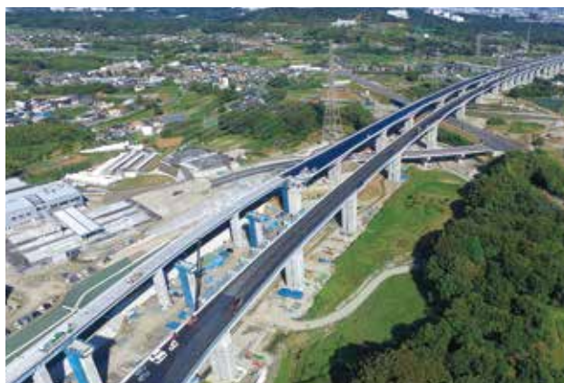
▲ 新東名高速道路 秋山高架橋
