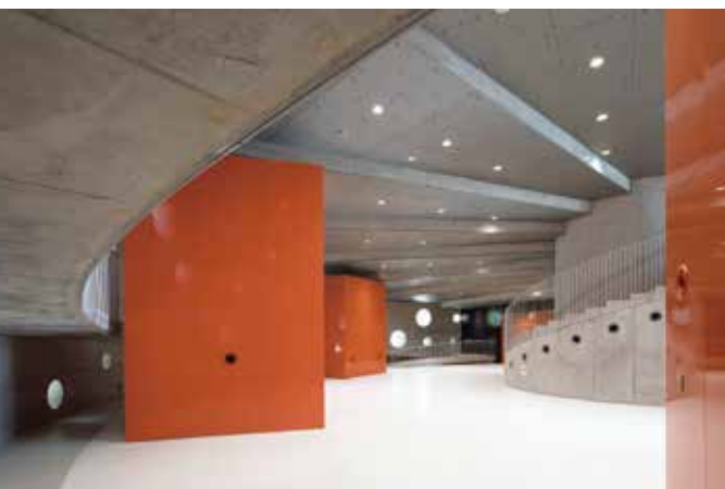
▲ 回廊屋根部に螺旋階段状に配置された場所打ち PC 梁
