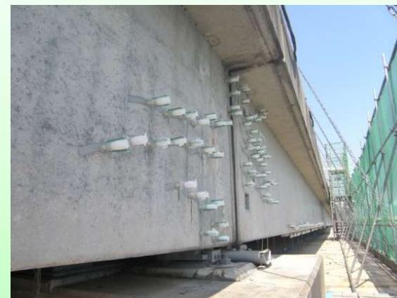
写真5. 4. 3 ひび割れ注入 工
